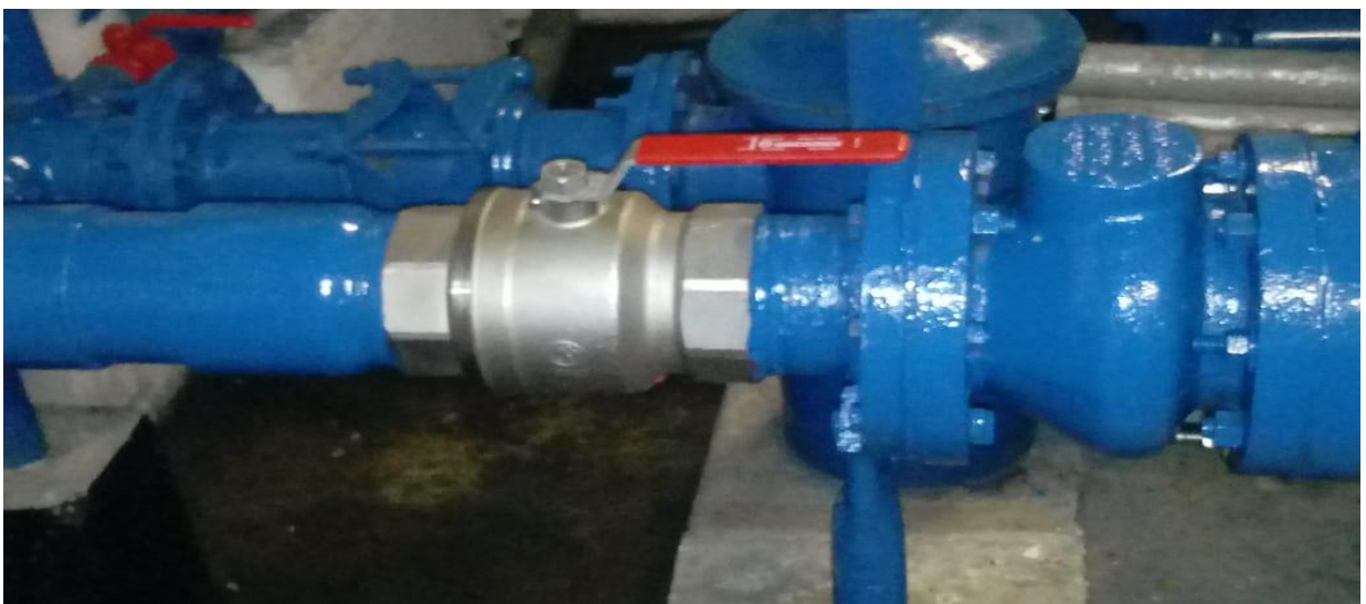
Se Instaló de 01 válvula de 6" pulgadas.
