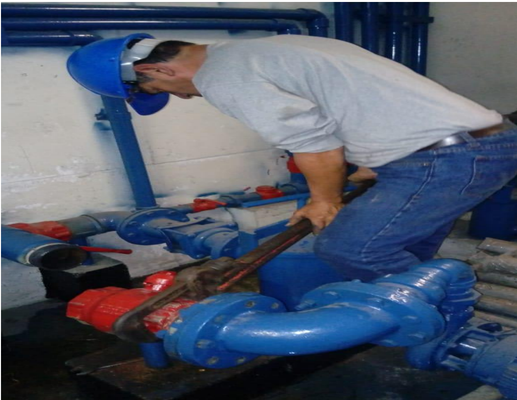
Válvula existente en mal estado, no cierra ni apertura.
