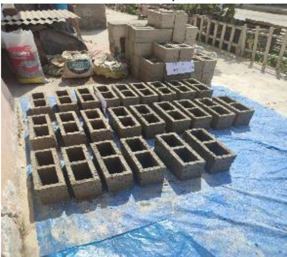
**Figura N°20:** Elaboración de ladrillos 1
