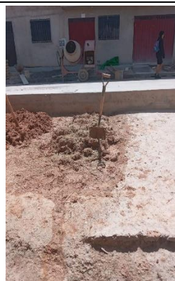
Figura35: Medición de adobera y mezcla de suelo con la incorporación de paja de trigo y fibra de cabuya
