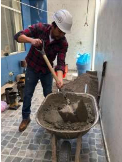
Fotografía 7 Cuchareo de mezcla posterior a su mezclado en mezcladora
