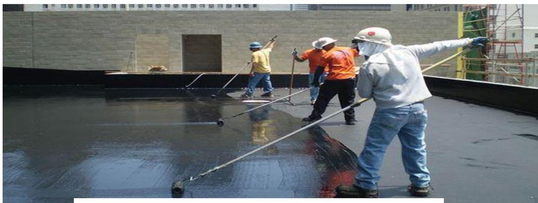
Figura: Impermeabilización de un techo. Recuperado: <https://www.pinterest.es/pin/52994708114754559>
