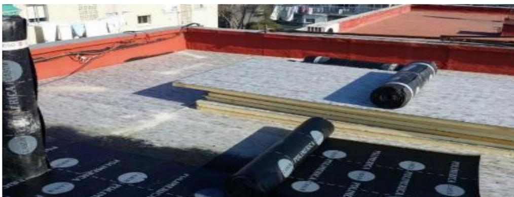
Figura: Proceso de impermeabilización de una cubierta. Recuperado: <http://www.boe.es/boe/dias/2017/10/23/pdfs/BOE-A-2017-12133.pdf>
