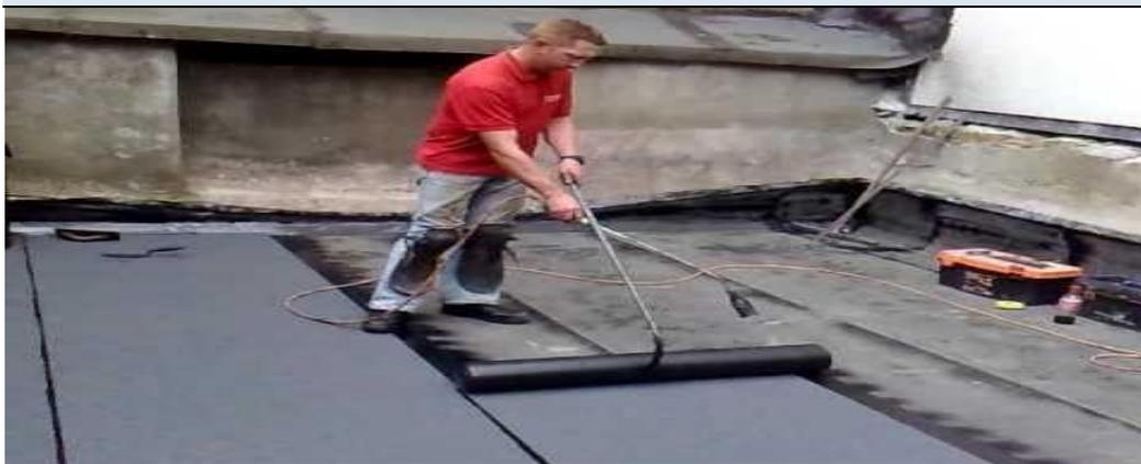
Figura: Proceso de impermeabilización. Recuperado: <https://www.pinterest.es/pin/664984701232975>
