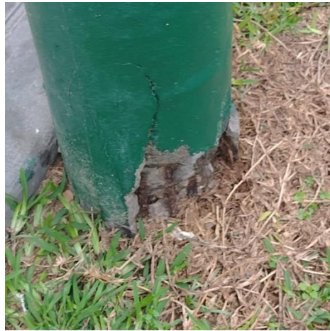
Foto 2. Corrosión de concreto
