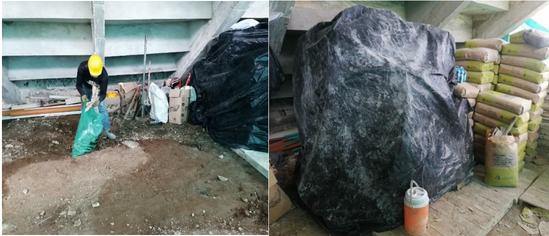
Figura 17. Imágenes del almacén después
