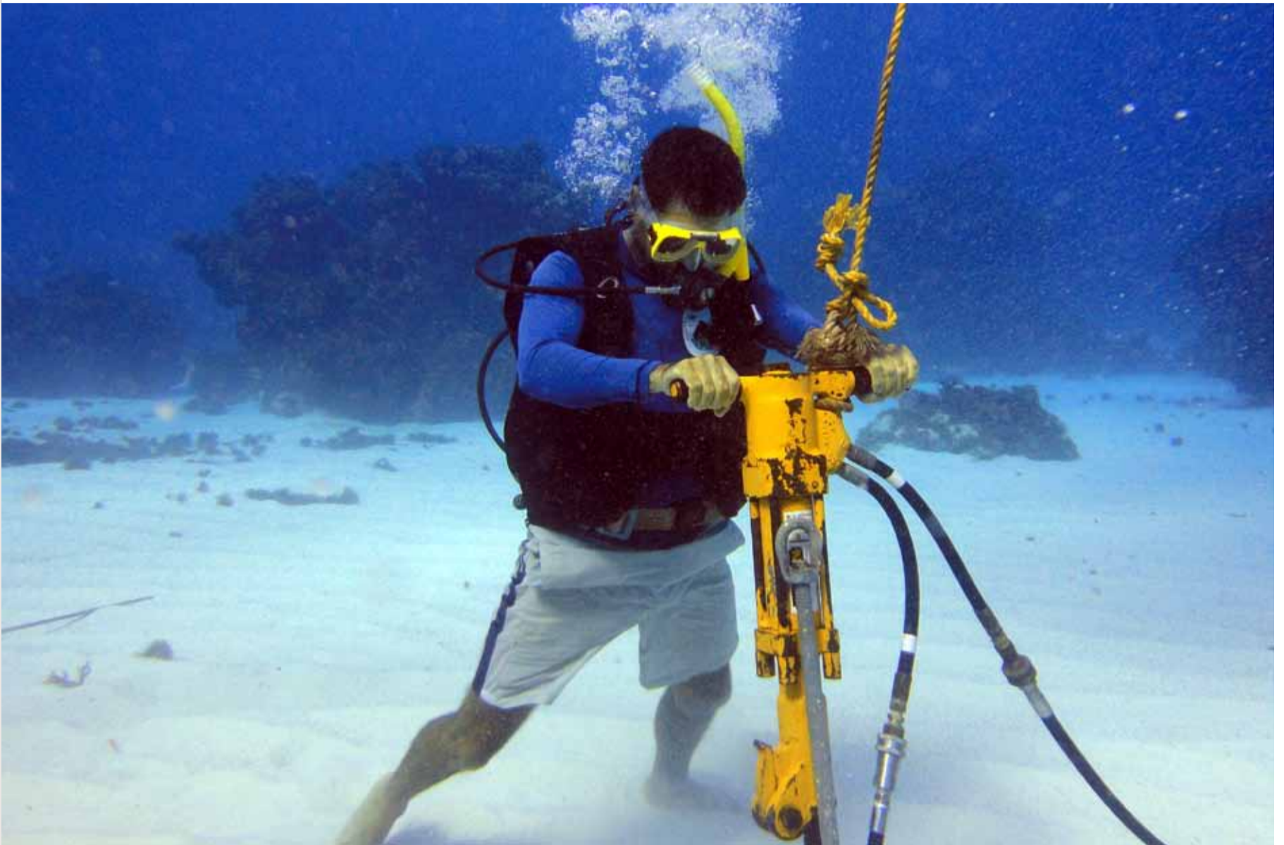
Foto 10. Esquema del sistema de anclaje de boyas de amarre y demarcación e ilustración de instalación finalizada (Foto: Archivo CORALINA).
