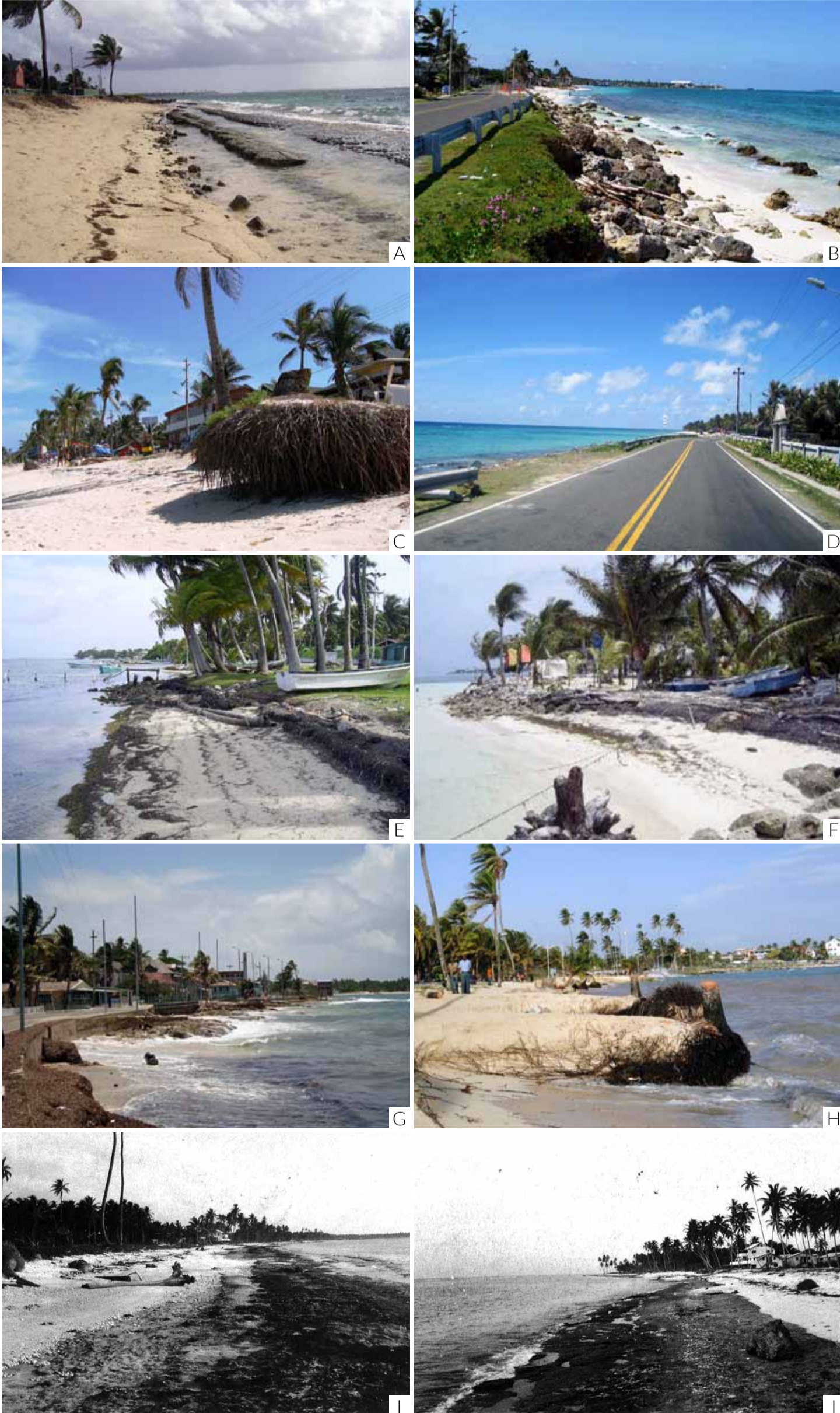
Foto 7. Registro de procesos de erosión en algunos sectores de la isla de San Andrés. a) en San Luis cerca al Decamerón (Foto programa GEO-INVEMAR); b) y c) Sound Bay (Fotos: Elizabeth Taylor, CORALINA), d) Erosión presentada en Sound Bay frente al cementerio (Foto: Carolina Segura Q., INVEMAR), e) la Mansión (Cocoplum Bay) (Foto: programa GEO-INVEMAR)) f) en las playas de Rocky Cay (Foto: programa GEO-INVEMAR), g) Sector Free Town San Luis (Foto: Ángela C. López, INVEMAR), h) Erosión observada en Sprat Bight (Foto: Elizabeth Taylor, CORALINA); i) Vista de la playa de Sound Bay en el año 1970 (Fotos: Geister Archivo CORALINA).
