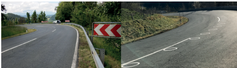
Abb. 6 Kurve vor und nach Anbringen der ellipsenförmigen Bodenmarkierung [66].
