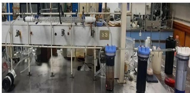
Figura 4. Tren de tratamiento de coagulación en línea filtración rápida.
