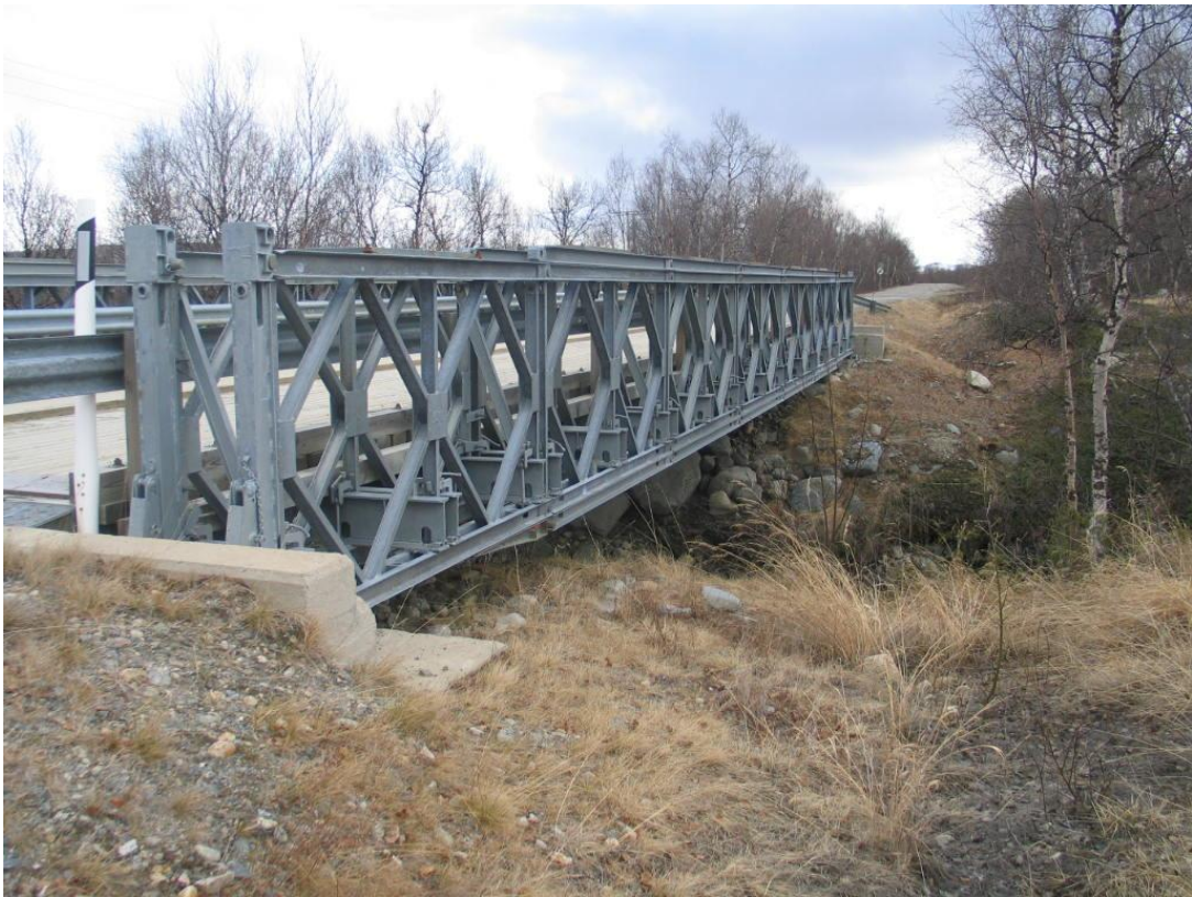
Kuva 4. Varasiltakalusto Bailey (Lehtinen 2023).
