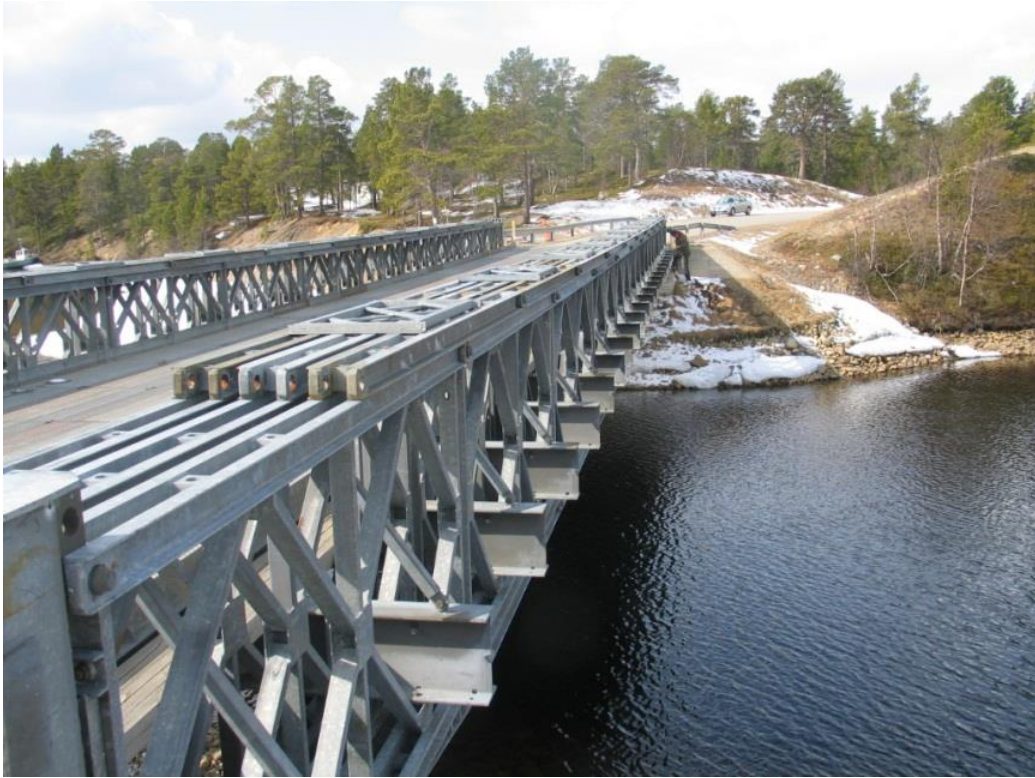
Kuva 3. Varasiltakalusto Acrow Panel (Lehtinen 2023).
