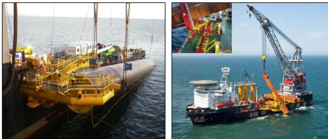
Figura 12 Instalación de monopilotes [68]
