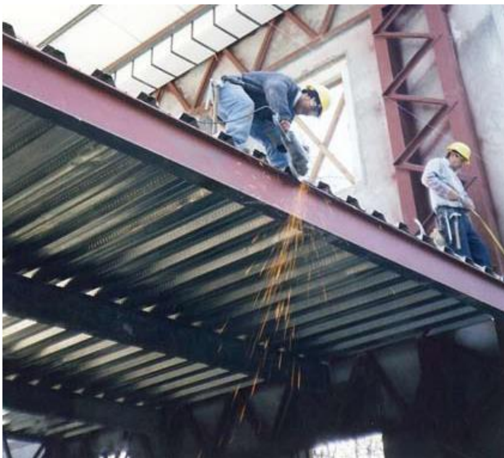
Fig. 119. Construcción de entrepiso mixto
