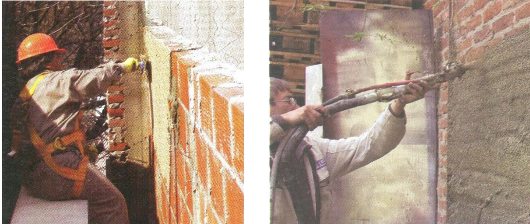
Fig. 158. Revocado de muros con revoques especiales
