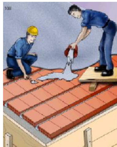
Fig. 128. Hormigonado
