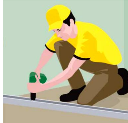
Fig. 81. Colocación del perfil solera
