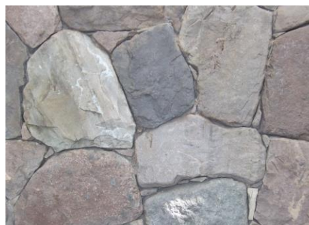
Fig. 69. Muro de piedra
