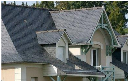
Fig. 140. Vivienda con techo de pizarra
