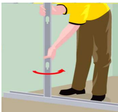
Fig. 83. Colocación del montante
