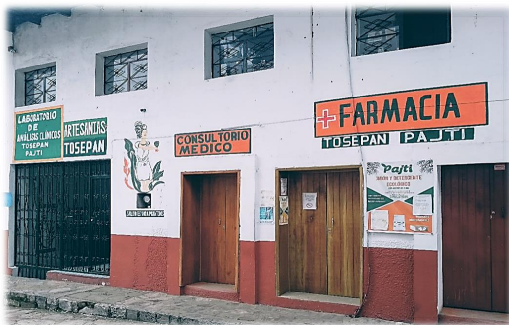
Figura 19 As instalações de parte da estrutura da cooperativa Tosepan Patji – laboratório de análises clínicas, consultório médico e farmácia, 2019.
