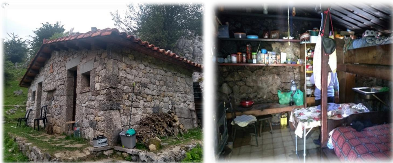
Figura 56 Exterior e interior de cabanas rehabilitadas para habitação das pastores-queijeiros do Puerto
