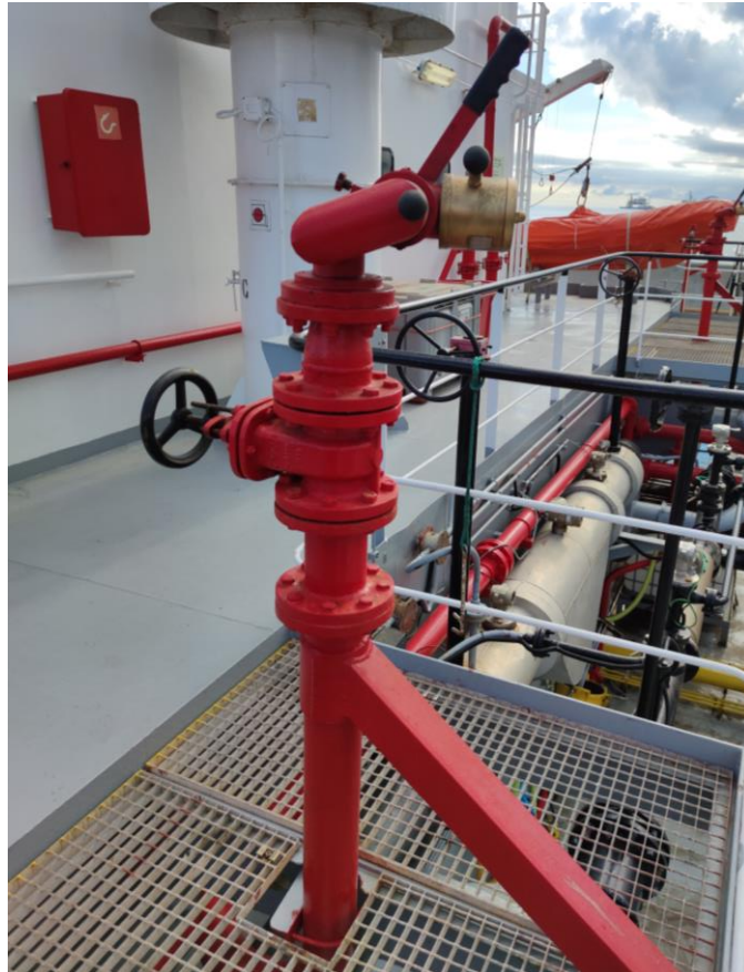
Ilustración 23. Monitor de espuma/agua de la banda de estribor. Fuente: elaboración propia.
