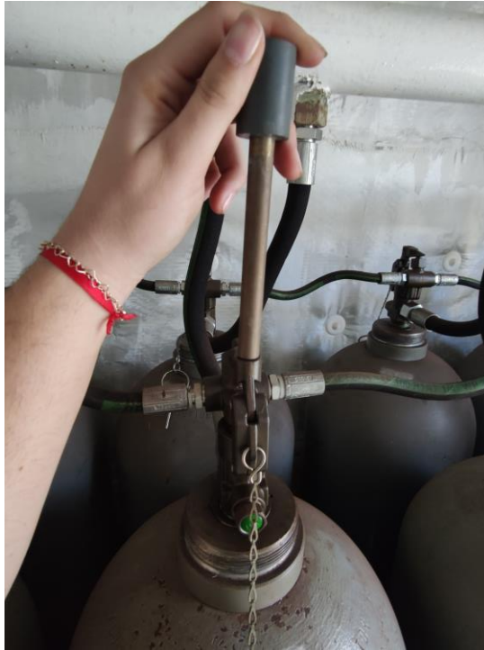
Ilustración 18. Palanca (G) introducida en la válvula de la botella CO 2 . Fuente: elaboración propia.
