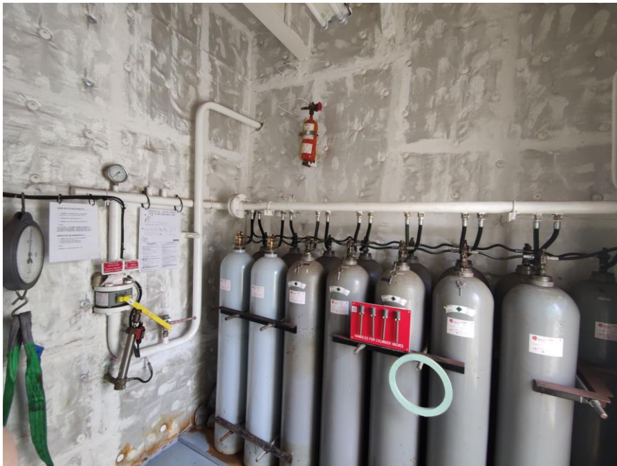
Ilustración 19. Local de CO 2 del buque "Spabunker Treinta". Fuente: elaboración propia.
