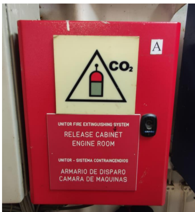
Ilustración 15. Armario de disparo de CO 2 del buque "Spabunker Treinta". Fuente: elaboración propia.
