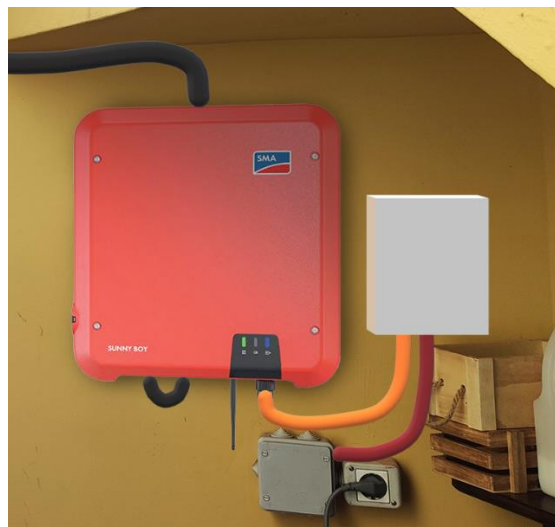
Figura 2.10. Simulación cableado de alterna.
