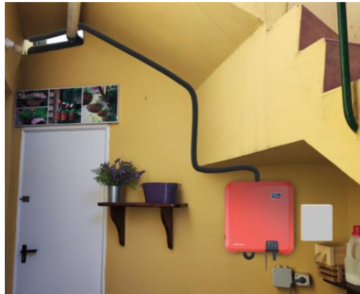
Figura 2.9. Simulación segundo tramo de cableado de continua.
