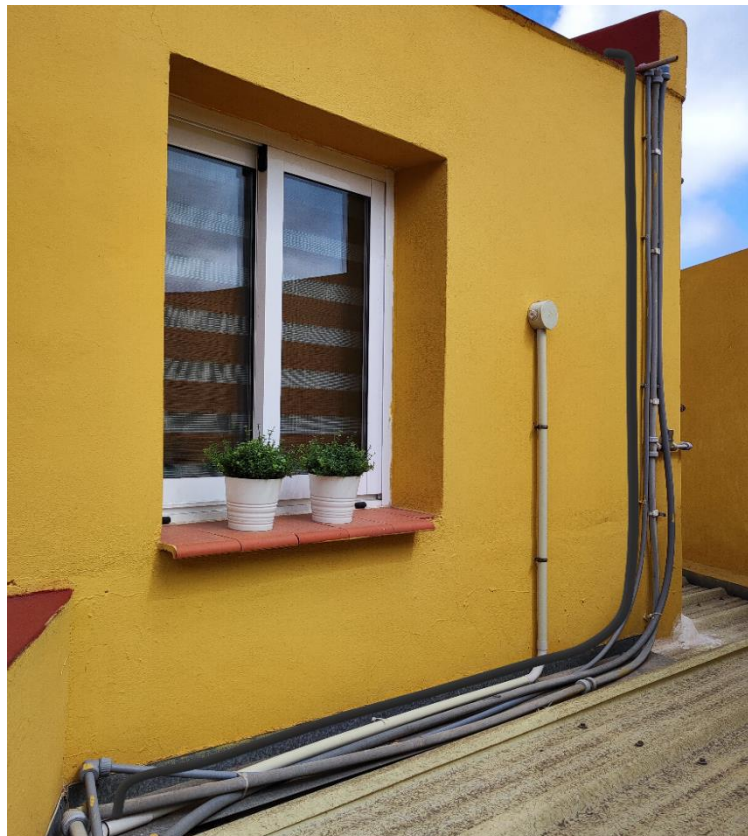
Figura 2.8. Simulación primer tramo de cableado de continua.
