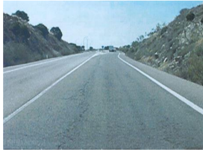
FIRME INTERSECCIÓN P.K. 24
