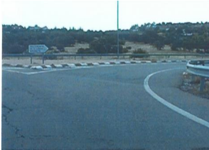
SALIDA GLORIETA COLMENAREJO P.K. 21,4
