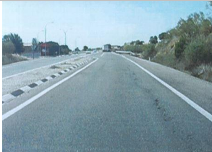
FIRME INTERSECCIÓN P.K. 24
