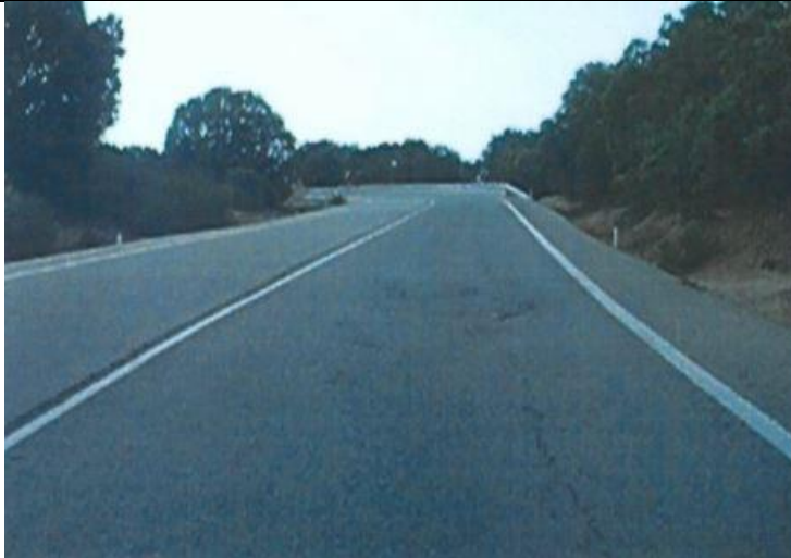
ESTADO FIRME TRAMO P.K. 20,7
