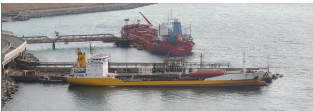
*Ilustración 60. Buque atracado en muelle ciego (delante) y buque atracado en duques de alba (detrás).*
