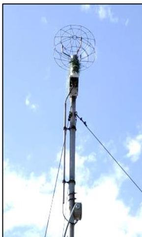
Ilustración 4. Anemómetro del terminal marítimo de Cepsa.
