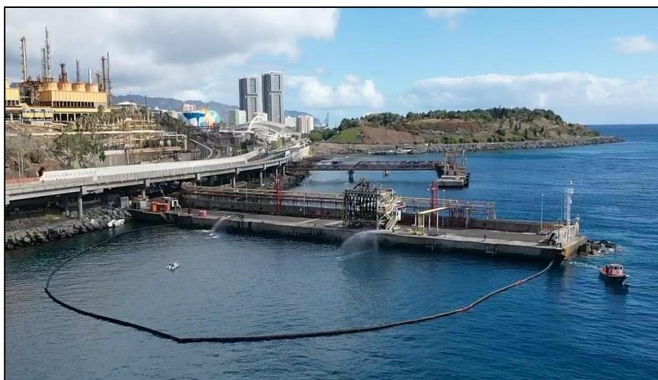
Ilustración 27. Despliegue de cerco en muelle ciego.
