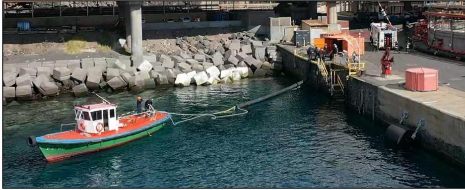
Ilustración 28. Despliegue de cerco con embarcación.
