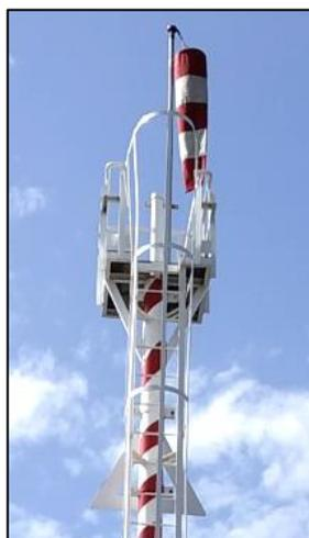
Ilustración 7. Manga de viento del terminal marítimo de Cepsa.
