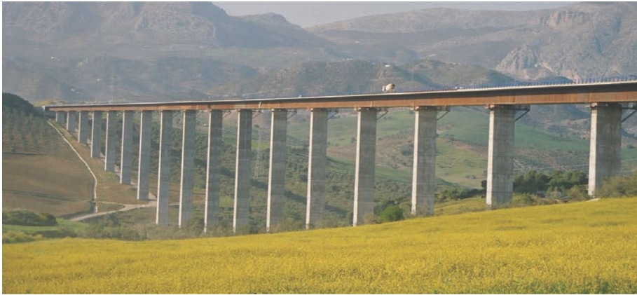
Fig. 1 Arroyo de las Piedras Viaduct. Madrid-Malaga high-speed line (Spain)
