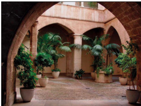
Fig. 1. Patio del Palau de l'Almirall de Valencia. En él se observa cómo los arcos apuntados muy rebajados del lado sur, sin duda los más tardíos, encajan abruptamente en los del lado oeste; los más antiguos, descansando sobre una pequeña ménsula o canecillo y rompiendo la simetría de esa panda.
