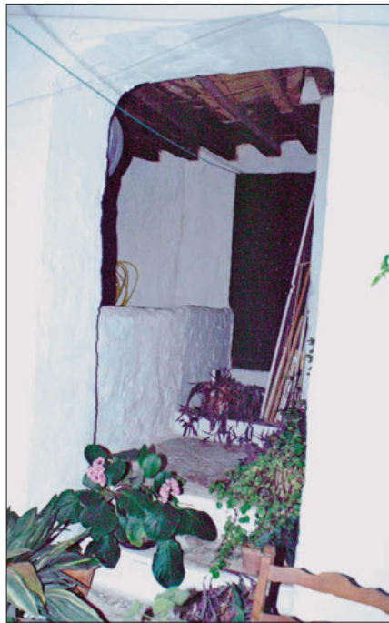
Fig. 18. Bajada del Pozo Amargo n.º 7. Entrada principal de una casa patio a principios del siglo XV, hoy destruida. El acceso se situaba en el n.º 7 del cobertizo del Pozo Amargo.
