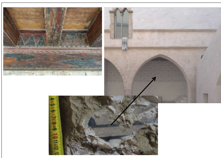
Fig. 7. Resto de la decoración parietal de parte del patio, ubicada en su localización original mediante infografía y detalle del alfarje que la acompañaba en el nuevo cuerpo construido en la segunda mitad del siglo XIV-principios del siglo XV.
