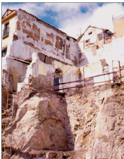
Fig. 15. Callejón de San Pedro n.º 18. El palacio principal del siglo XII, antes de su demolición para poner un ascensor.
