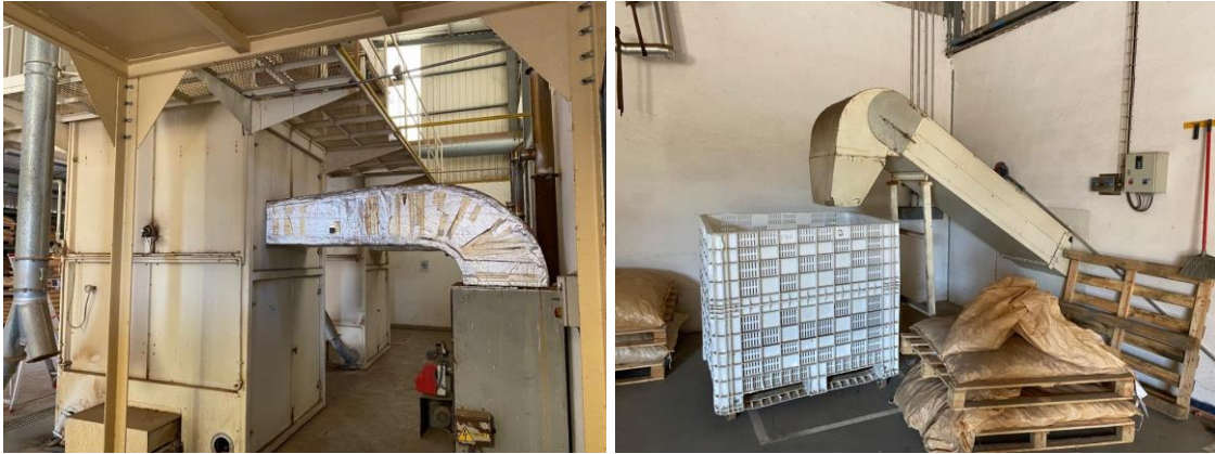
figura 3-20 Anexo do Revestimento
