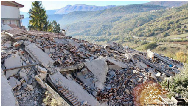
Figura 4 Destruição em L'Aquila, 30 de Outubro de 2016
