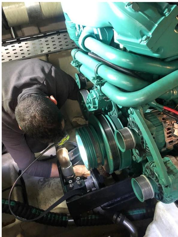
Figura 6.11 - Substituição da Correia do Alternador
