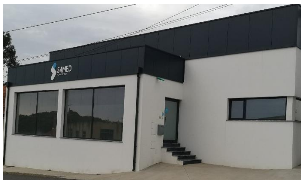
Figura 3 – Novas instalações da empresa S4MED – Medical Devices
