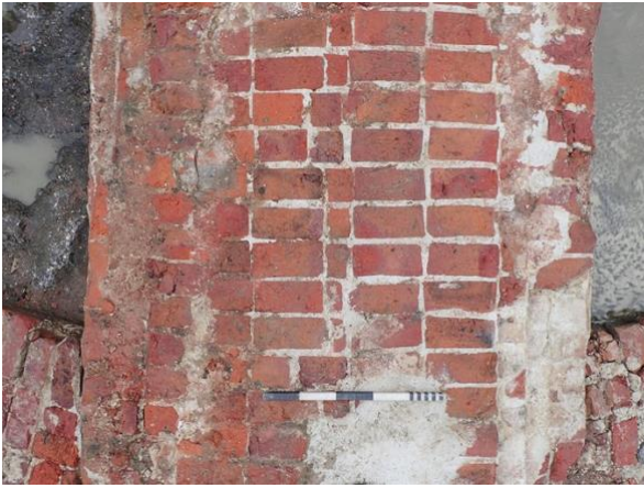
Figuur 27: detail van de muur tussen de middelste en de westelijke kamer met onderaan de bouwnaden van de draaiplatformen (© Fodio)
