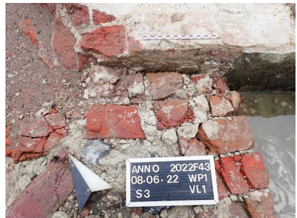
Figuur 34: de bouwnaad tussen FU3 en MU1. Het draaiplatform is tegen de bepleistering aangebouwd(© Fodio).
