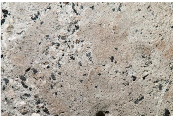
Figuur 45: bovenzvlak van vloer VR6 (v6.1) (©Fodio).
