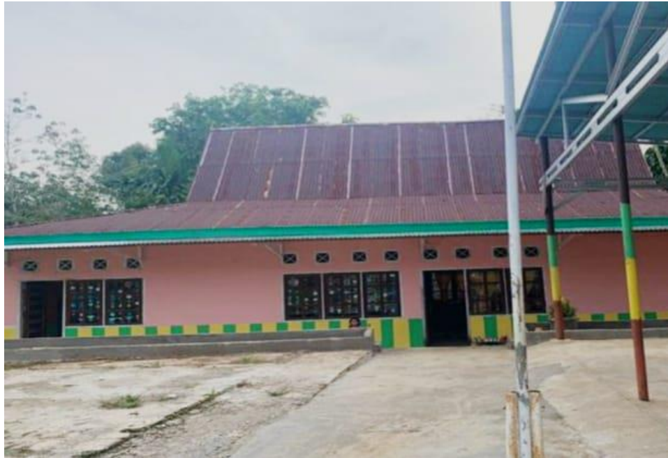
Gambar : Gedung Sekolah TK Pertiwi
