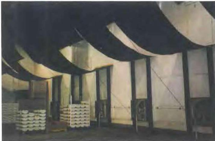
Foto 5. Túneles de pre-enfriado por aire forzado.
