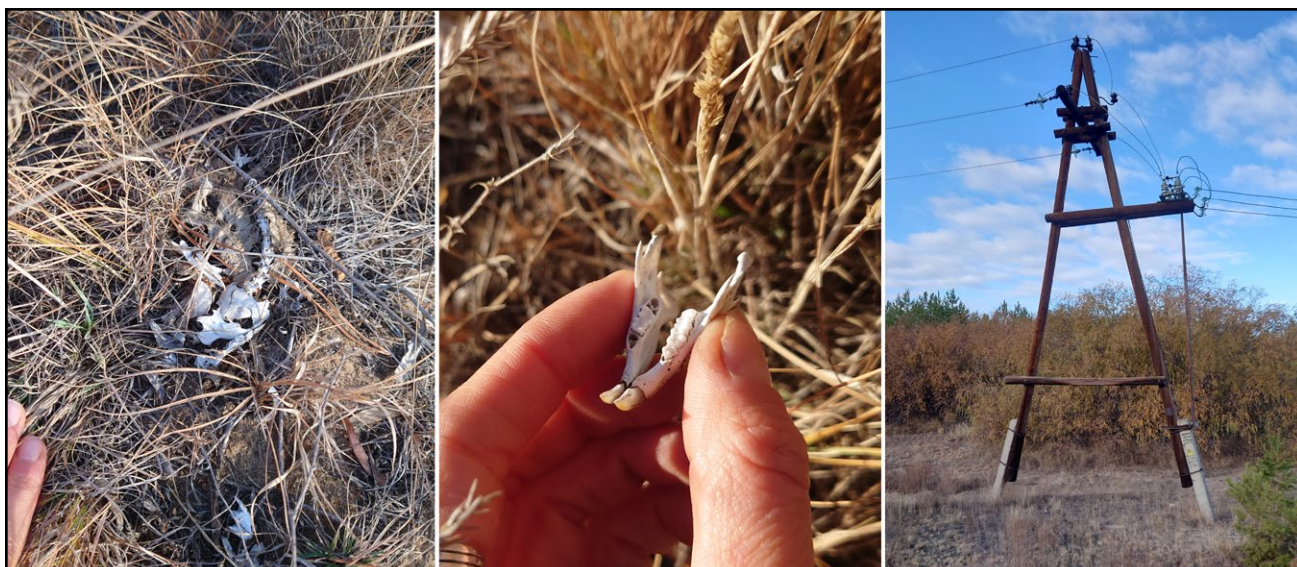
Рис. 11. Останки белки под деревянной анкерной опорой с линейным разъединителем. Фото Е. Шнайдер.
