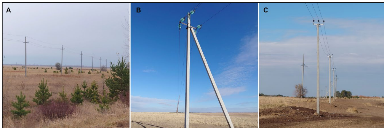
Рис. 2. Примеры осмотренных линий: А – Линия на бетонных опорах со штыревыми изоляторами; В – Линия на деревянных промежуточных опорах, усиленная бетонными анкерами. С – Линия на СИП-3. Фото Е. Шнайдер.
