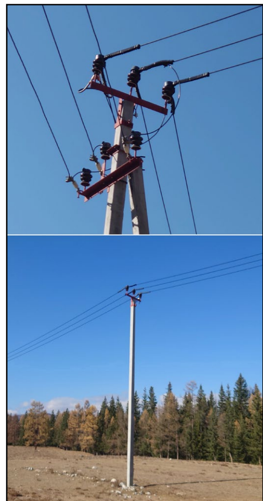
Рис. 4. Линия на СИП-3 с надетыми кожухами ПЗУ. Фото Е. Шнайдер.
