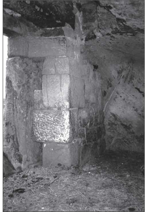
FIGURA 14. Muro este de la puerta principal. En esta toma podemos comprobar el sistema mixto de construcción. Sillería-terreno natural o rupestre.
