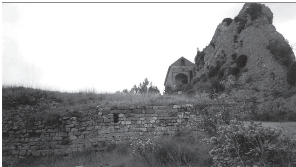
FIGURA 2. En primer plano restos de la muralla de Castro Bilibio. Sobre ella la ermita de San Felices.
