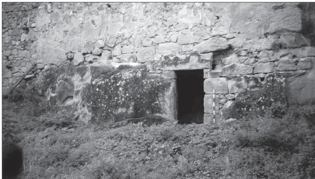
FIGURA 8. Vista general del exterior de la iglesia rupestre de Paceta.
