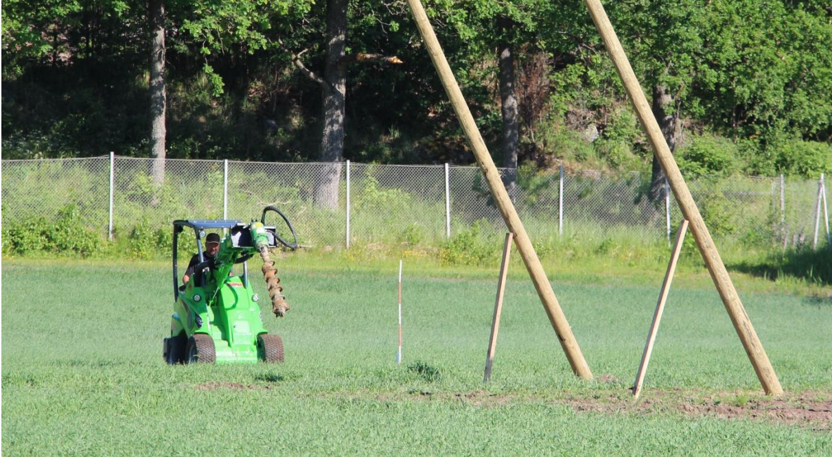
Kuva 23. Pylväskaira (maapora) on hyvä työkonne pylväiden asennukseen, koska silloin reikä pysyy tiiviinä eikä maa löysty pylvään ympärillä; tiivistämistyötä tarvitaan vähemmän. Kuva: Saara Tuohimetsä, Luke.
