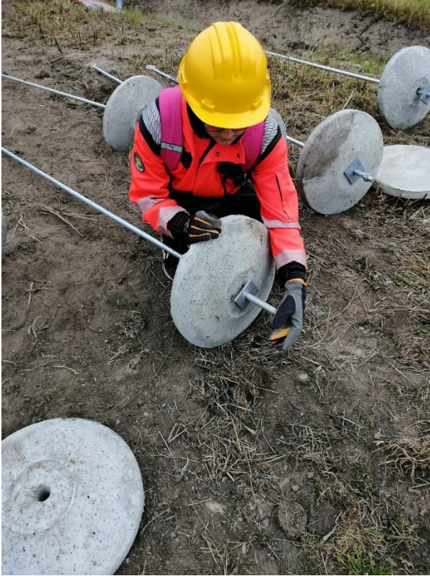
Kuva 33. Jamissa humalatarhan tukivaijerit ankkuroitiin valmiina hankittuihin betonisiin ha- ruslaattoihin, jotka oli helppo upottaa kaivinkonekuoppaan maahan. Kuva: Henna Latvala, Jami 4.9.2020.
