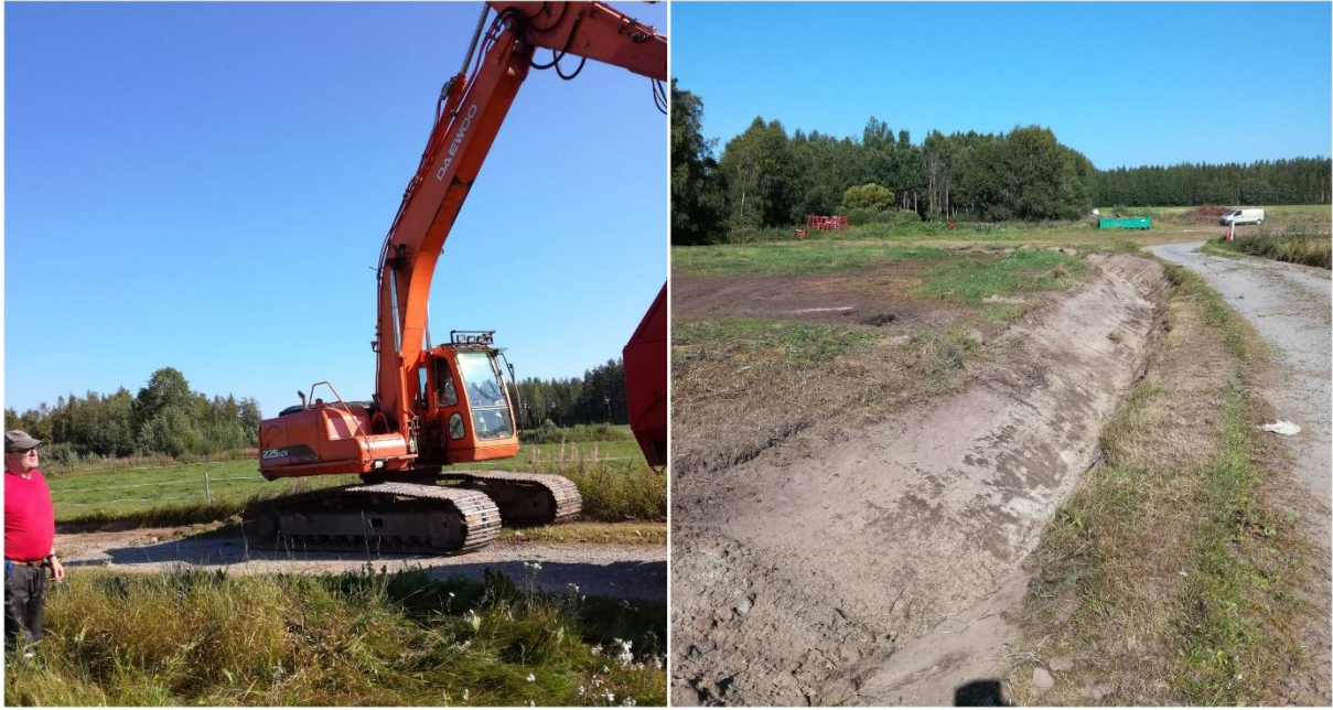
Kuva 29. Humalatarhan peltolohkon ympärysojat perattiin kaivinkoneella urakointipalveluna. Kuva: Henna Latvala, Jami.
