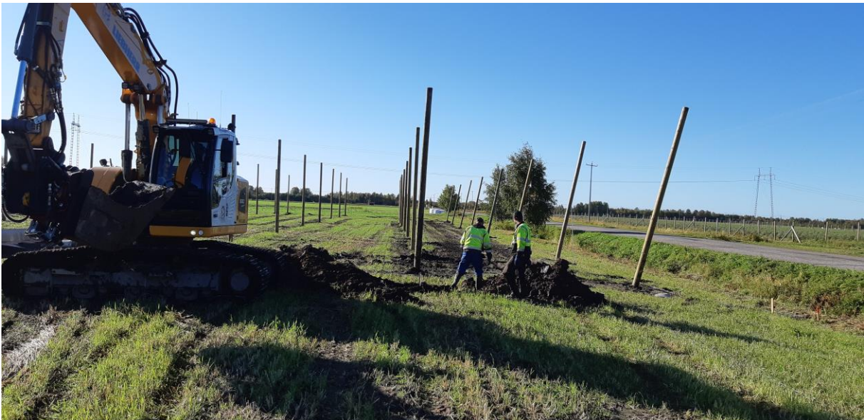
Kuva 42. Humalatarhan tolppien asennus Lappian Louen tilalla. Kuva: Jarmo Saariniemi, Lappia 9.9.2020.
