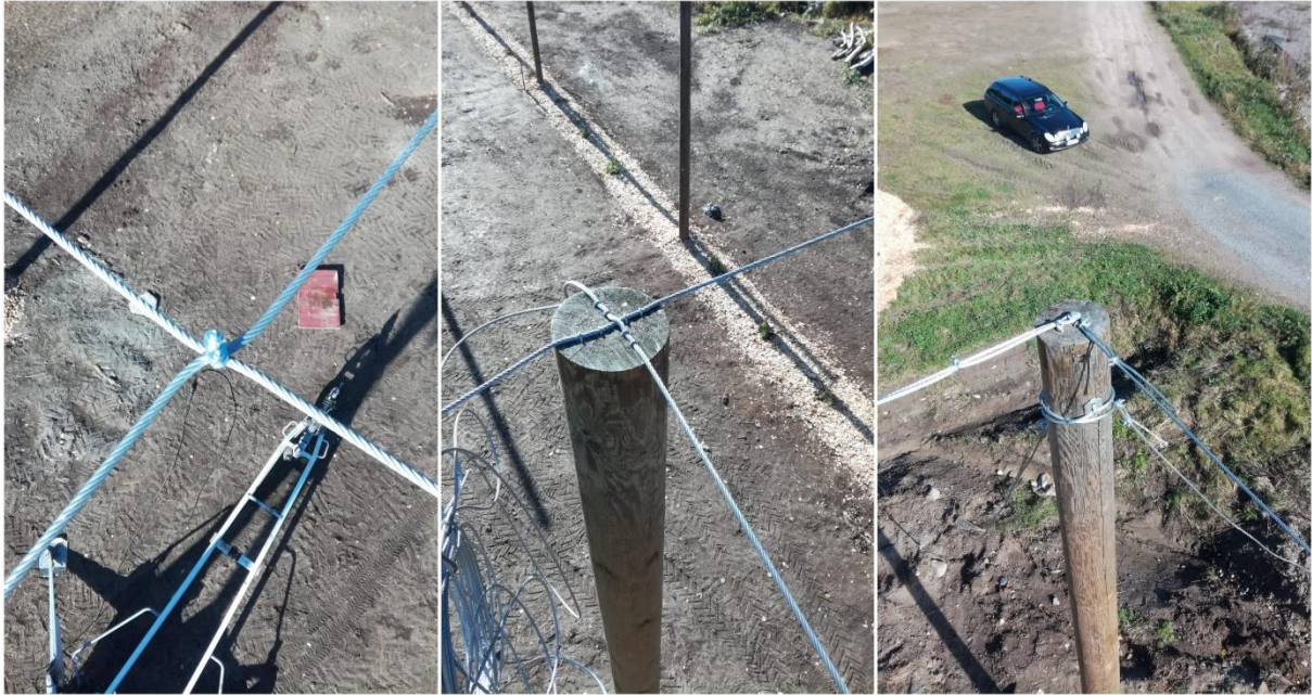
Kuva 35. Tarhan tukivaijeriston kiinnityksiä. Kuva: Henna Latvala ja Aimo Huopana, Jami.
