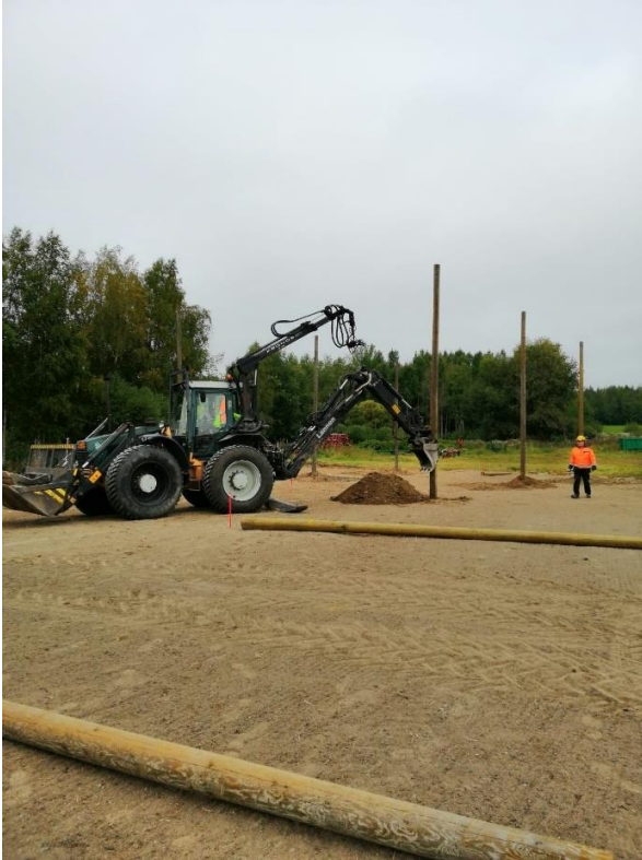
Kuva 31. Tarhan tolpat pystytettiin tolppavarustuksella olevalla traktorikaivinkoneella. Kuva: Henna Latvala, Jami 3.9.2020.
