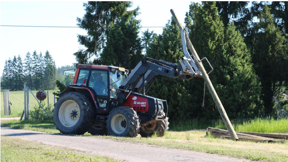
Kuva 24. Pylväiden asennukseen käytettiin suursäkinostimella varustettua etukuormaintraktoria ja nostoketjua. Nostoketju oli kiinnitetty pylvään ympäri siten että se kiristyi pylvästä nostettaessa ja pylvään alapää saatiin kuljetuksen ajaksi nousemaan irti maasta. Luke Piikkiön humalatarhan rakentamisessa käytetyt kestopuupylväät olivat ilmoitettu latvaläpimitaltaan min. 13 cm paksuiksi. Tyvi oli n. 18–23 cm. Pylväät upotettiin 130 cm syvyyteen ja pystysuoraan asennetut pylväät tasattiin latvoista 6 m korkeuteen, koska vinosti asennettaviksi pylväiksi käytettiin samoja pylväitä. Kuva: Saara Tuohimetsä, Luke.
