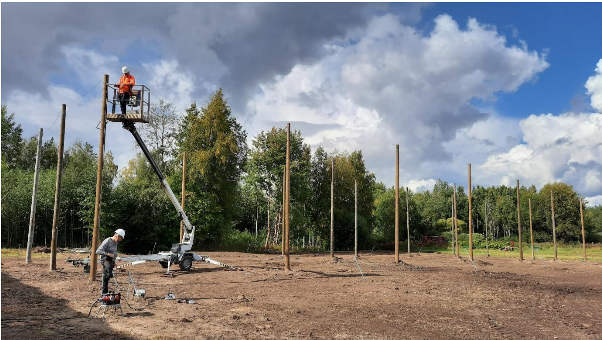
Kuva 34. Vaijerien asennus Jamin humalatarhaan. Kuva: Saara Tuohimetsä, Luke 7.9.2020.
