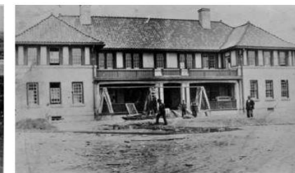
Cabaña en construcción, Hospital Ontario Whitby, 1916
