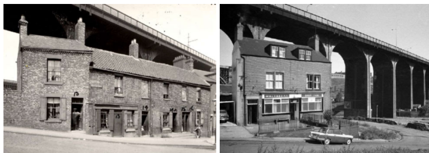
FIGURA 2. Imágenes de los arcos del viaducto del Ouseburn (1839) antes y después de la limpieza de espacios residenciales en los 60.
