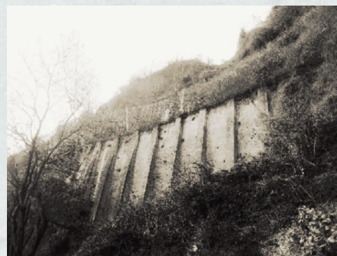
Muro de contención al oeste de la intervención.
