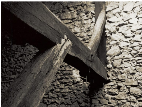
Anclaje de estructura de madera a muro de piedra.
