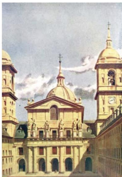
Figura 10: Fachada principal de la iglesia del Monasterio de San Lorenzo de EL Escorial
