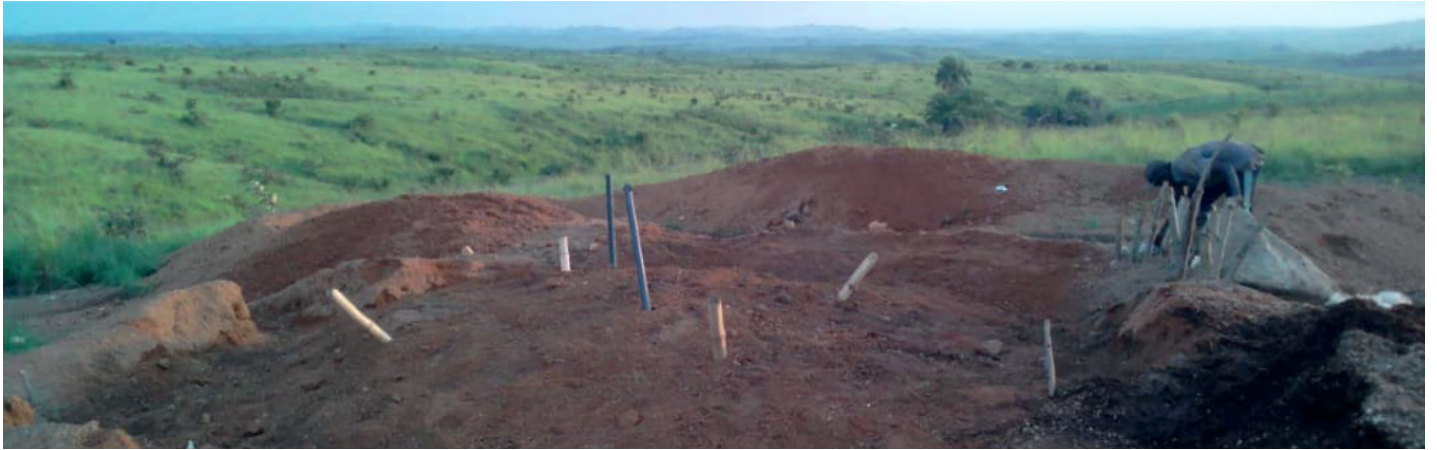
Figura 8.3.14. Vertedero sellado y con las chimeneas colocadas.
