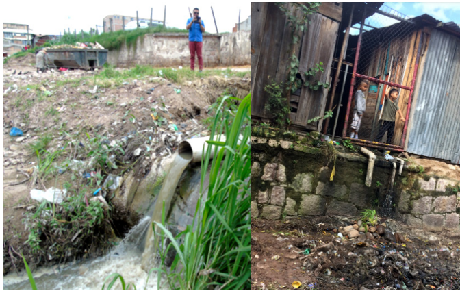
Figura 6.3.5. Mercado de Tegucigalpa con las tuberías rotas.
