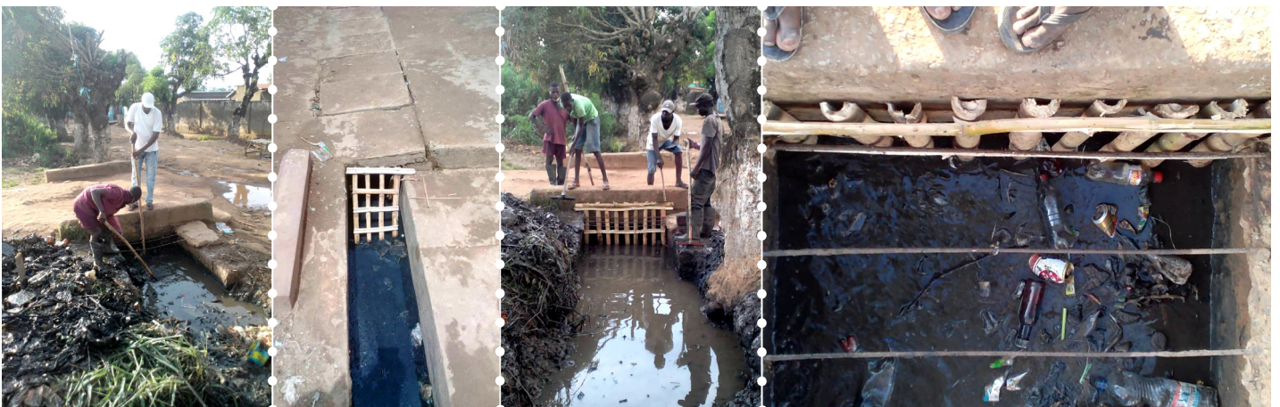
Figura 6.3.3. De izquierda a derecha: limpieza del canal, rejas colocadas y protección para sólidos de gran tamaño delante de la reja vista desde arriba
