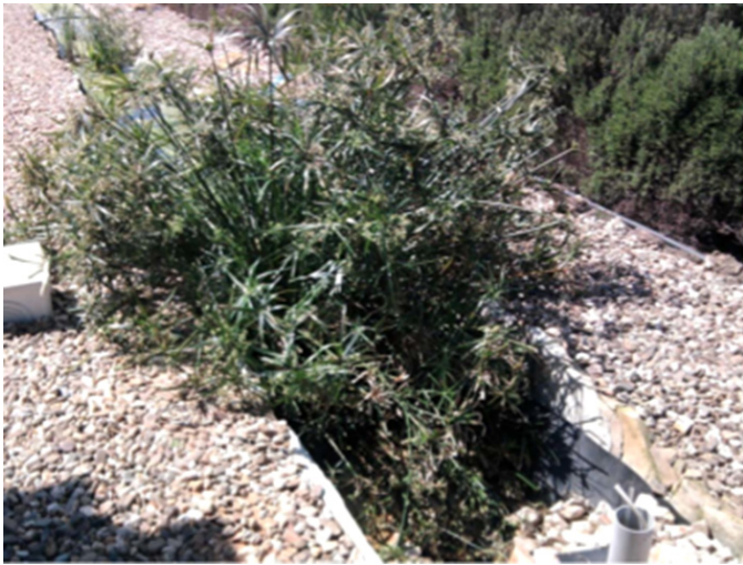
Figura 7.3.4. Paragüitas en el primer tramo.
