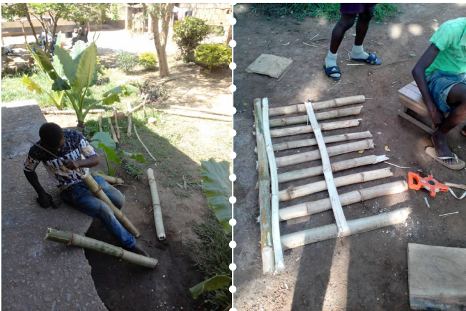
Figura 6.3.2. Construcción de las rejas para el saneamiento.
