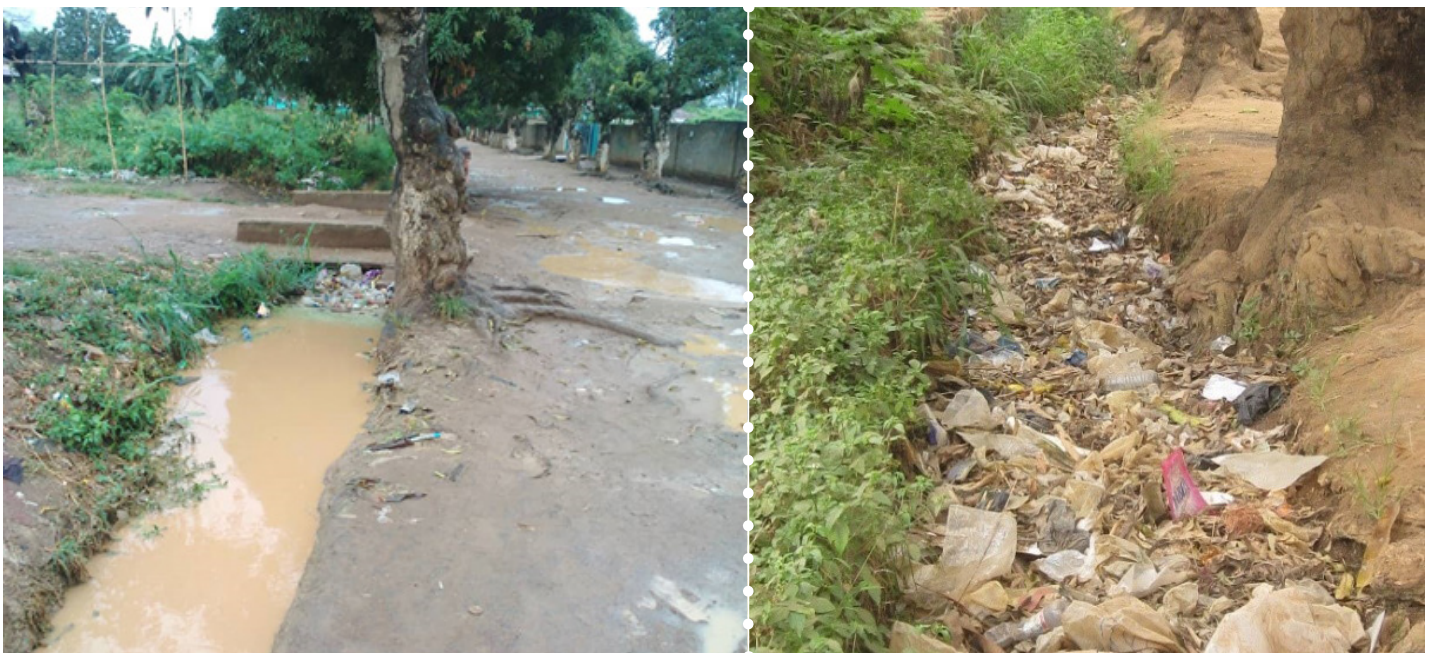
Figura 5.3.1. Canal de evacuación de agua pluviales del Mercado de domingo. Fue construido por la administración pública provincial pero no cementado. La foto de la izquierda está tomada en la estación lluviosa mientras que a la derecha es la misma foto en la estación seca.
