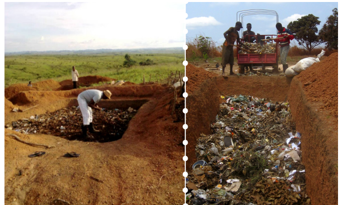
Figura 8.3.13. Relleno del vertedero por capas.
