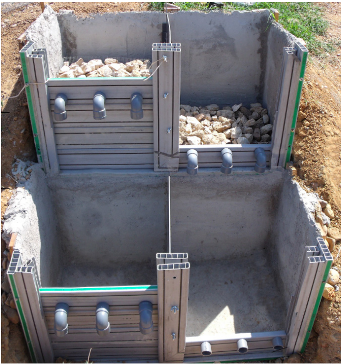
Figura 7.3.11. Prototipo de la escalera de oxigenación.
