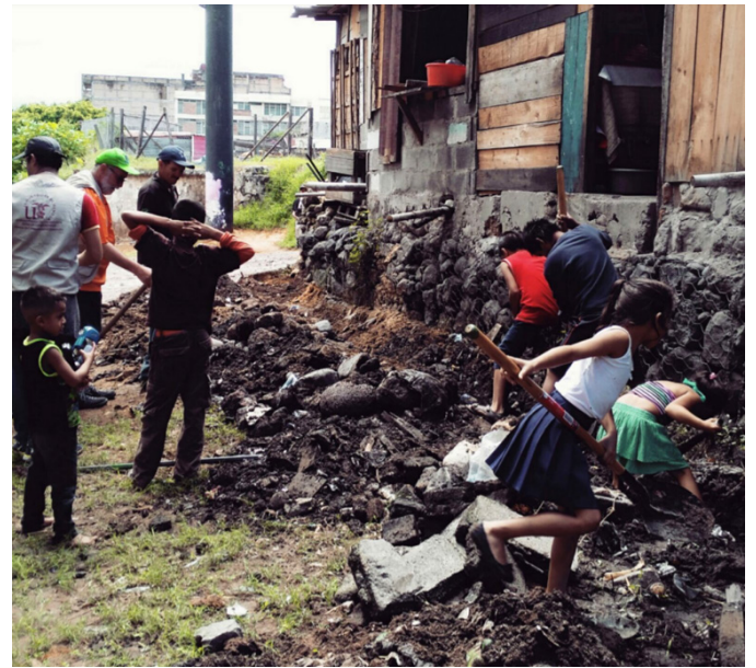
Figura 6.3.6. Saneamiento y excavación de las zanjas.
