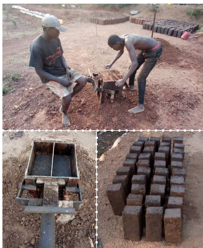
Figura 3.2.1. Moldeado y secado de los ladrillos de adobe en Kimpese
