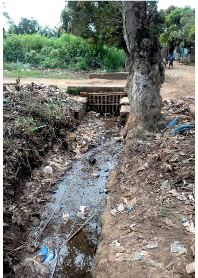
Figura 6.3.4. Canal con reja de saneamiento y la basura sin recoger.
