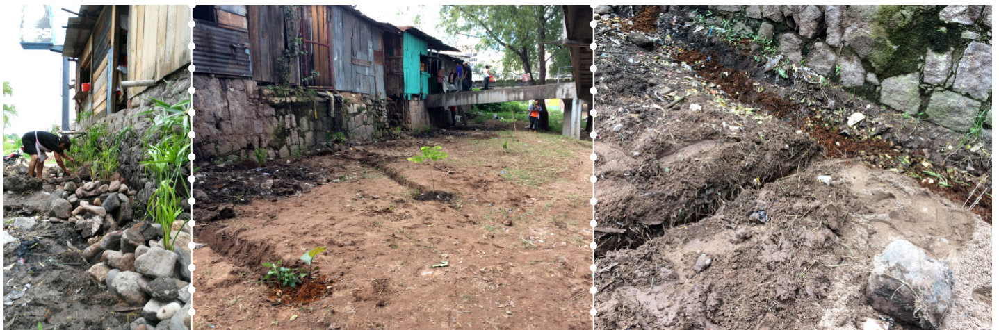
Figura 6.3.8. Piedras para oxigenar el agua al caer y zanjas naturalizadas.
