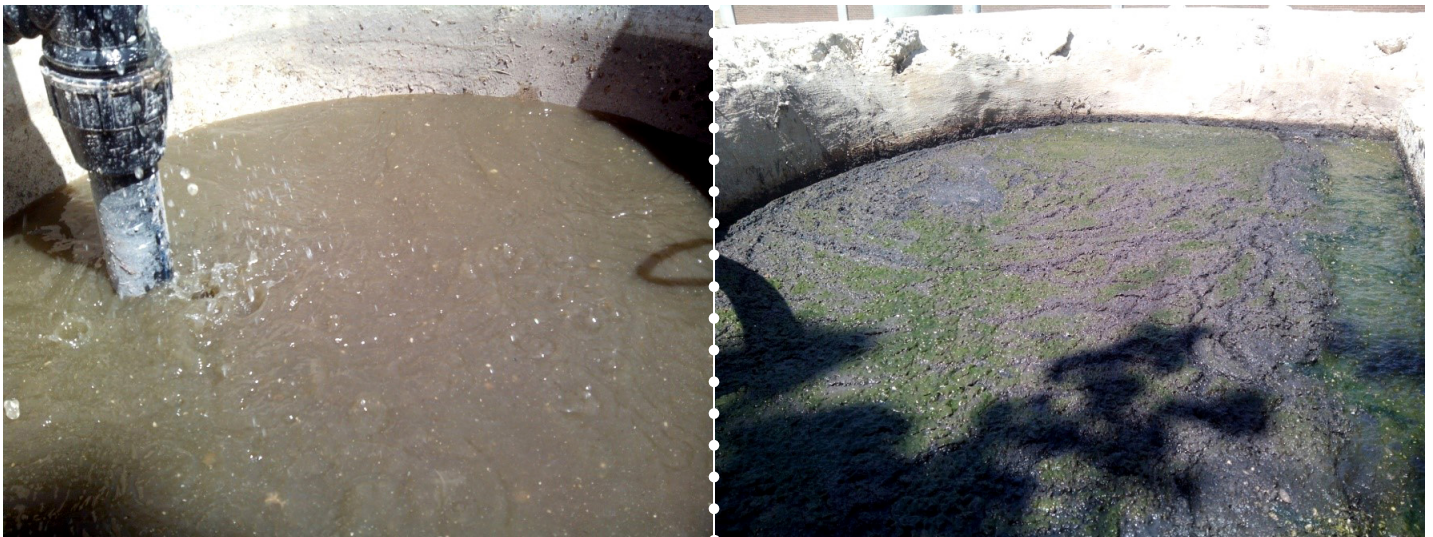
Figura 7.3.3. A la izquierda la fase de llenado y a la derecha la fase de operación.
