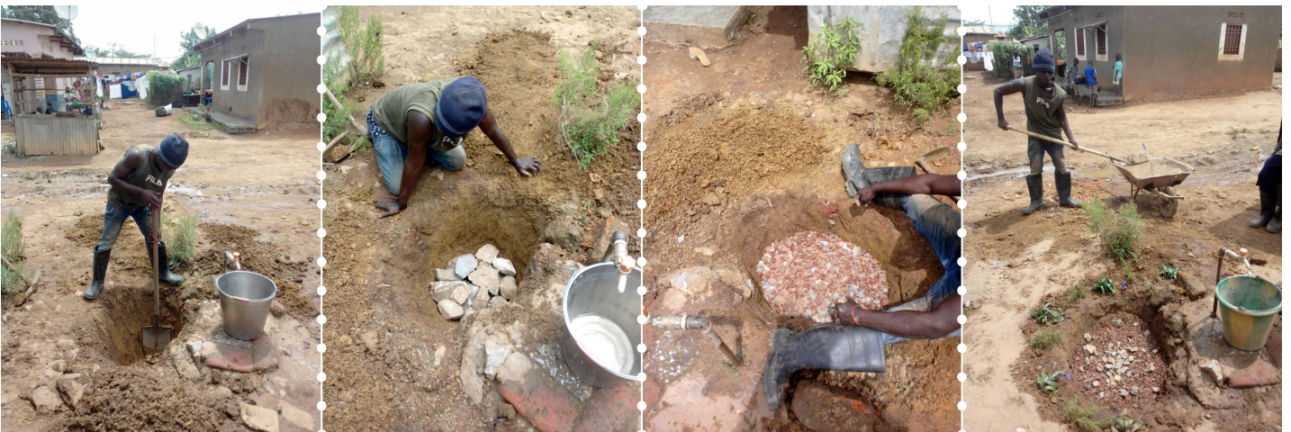
Figura 5.3.7. Apertura de un hoyo circular en el lugar donde se acumula el agua, con una profundidad de 1m. Colocaron piedras del tamaño de una palma de mano, con un grosor de unos 20 cm, seguida por piedras de menor tamaño hasta la tierra fina de la superficie.
