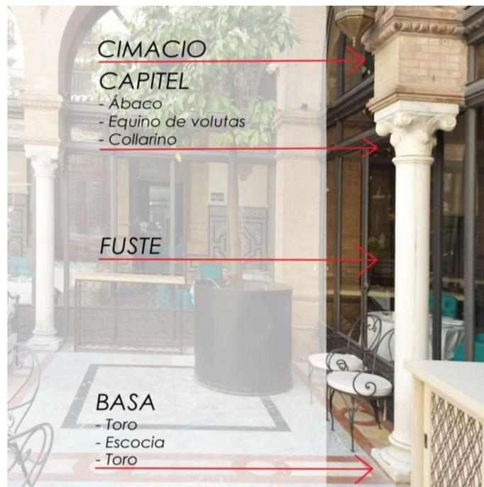
*Ilustración 19: Definición de las partes que conforman las columnas de mármol del patio. Fuente: Elaboración propia.*
