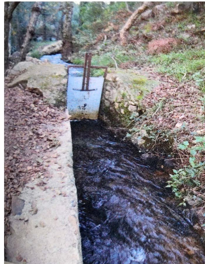
Figura 3.7 Autor Pedro Ríos. Compuerta del cao del molino de Escalona. Tomado de Ríos y de Vicente (2020). Pág. 109.
