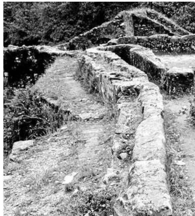
Figura 1.1 Canal de buena cantería para el abastecimiento de agua al molino del Águila. Tomado de Torremocha (2020, 23 mayo). [Fotografía]. https://www.europasur.es/algeciras/molinos-harinos-rio-Miel_0_1466853919.html .
