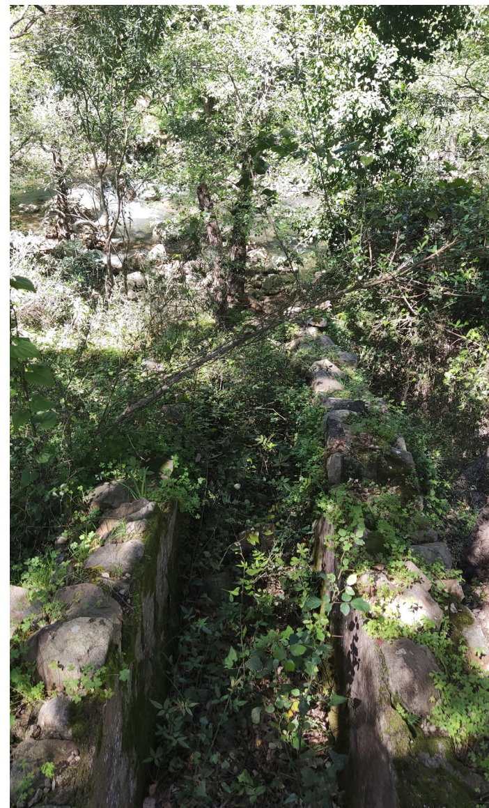
Figura 4.30 Evacuación de agua del conjunto de molinos de San Martín y San Cayetano (2022). Autora.
