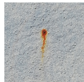
Fig. 44: Mancha por oxidación. Mural de Lalone, Av. La Soleá. Elaboración propia. Fecha: 20/03/2021.
