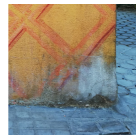
Fig. 48: Pérdida de película pictórica por disgregación causada por orines. Pintura de C. Steen, Av. la Soleá. Elaboración propia. Fecha: 20/03/2021.
