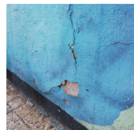
Fig. 43: Levantamiento de película pictórica en el mural de AEC, Calle Éfeso. Elaboración propia. Fecha: 01/06/2021.
