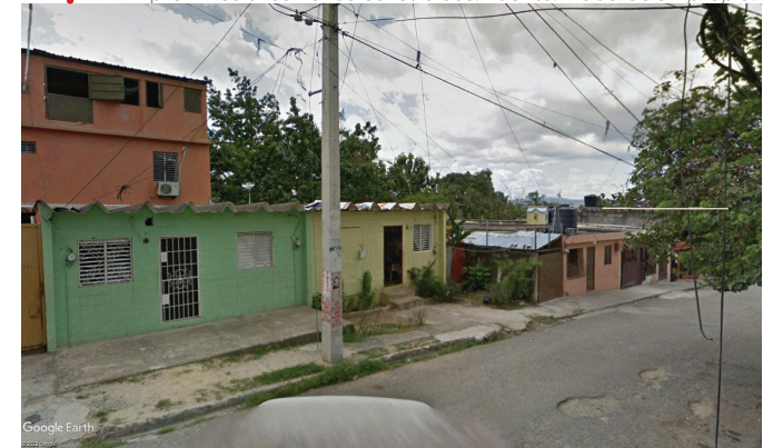
Figura 97. Casas construidas en Obras Públicas. Fuente: Google Earth .
