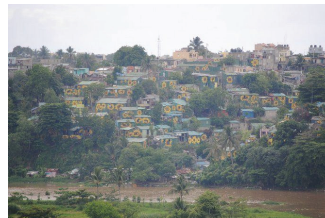
Figura 25. Fachada de Girasoles en el sector Simón Bolívar Fuente: Francisco Orgaz Agüera .
