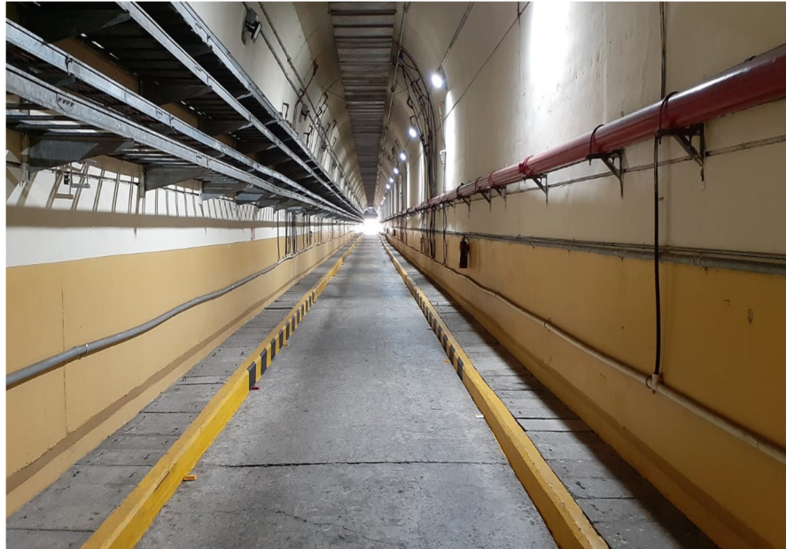
Túnel de casa de máquinas Pucará.
