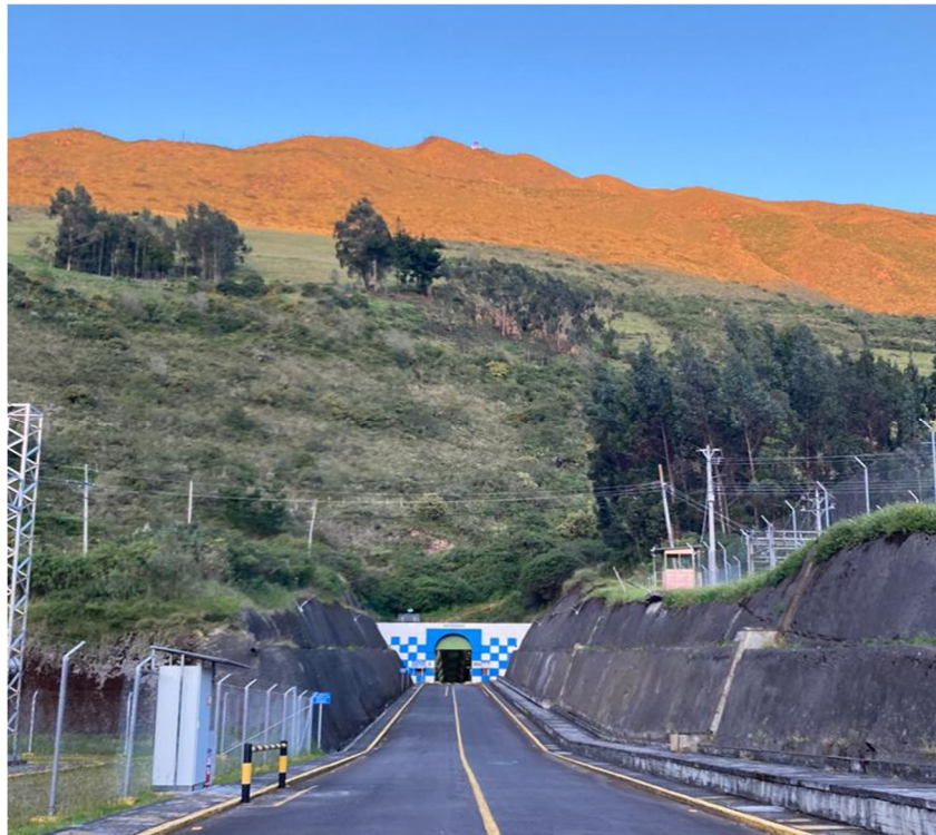
Túnel de acceso a casa de máquinas Pucará.
