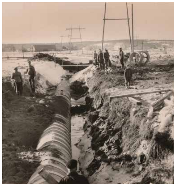
Kuva 5.2 Viemäri valmistumassa Seinäjoen Joupinkylään vuonna 1959. (Joupinkylän viemäryömaa. Porstua-verkkopalvelu.)
