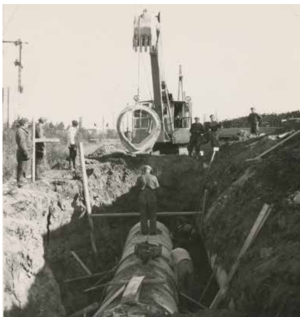
Kuva 5.1 Pääviemäri rakenteilla Seinäjoen Itikan alueella syyskuussa 1952. (Mäkinen 2011)
