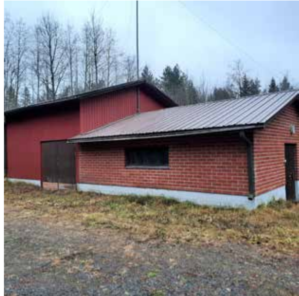
Sikaharjun vanha vesilaitos.
