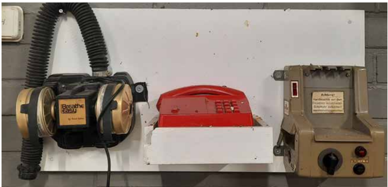
Vanhoja laitteita jätevedenpuhdistamolla.
