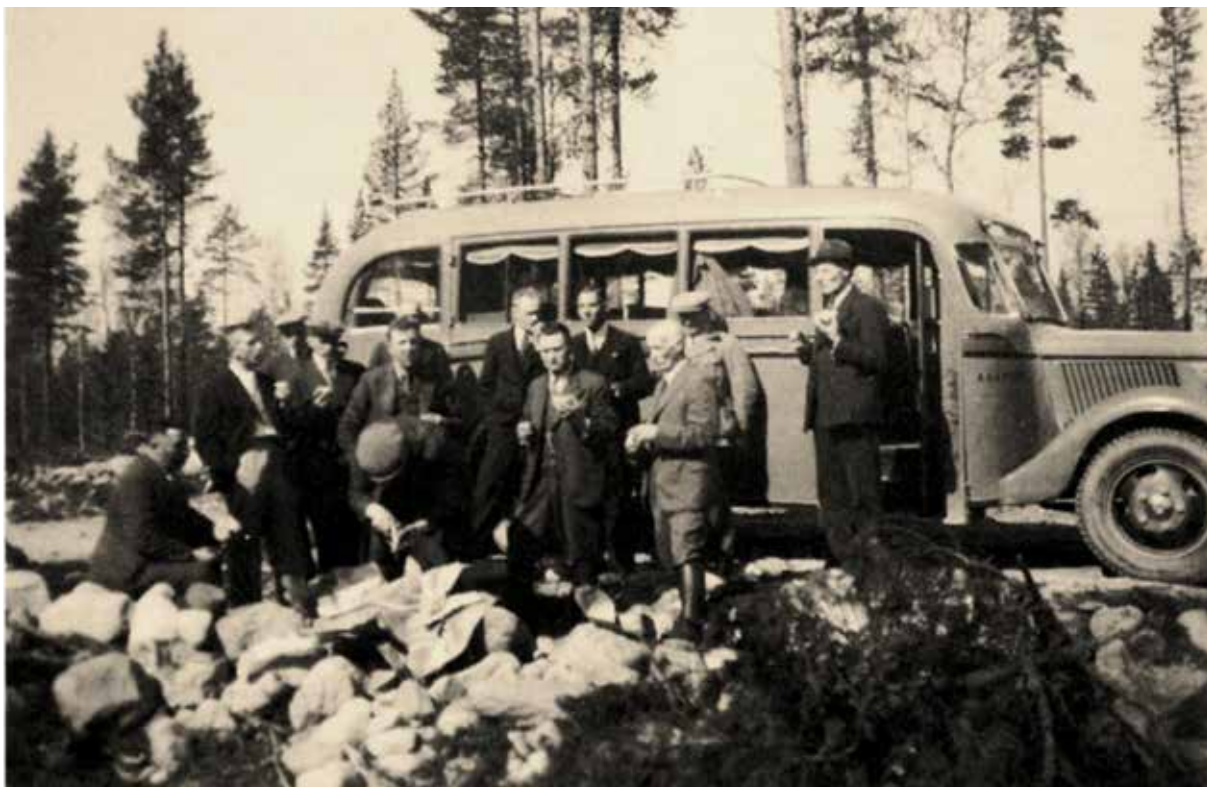
Seinäjoen Vesijohto Oy:n miehiä 1930-luvun lopun kuivana kesänä tutustumassa Seinäjärvellä Östermyran ruukia varten rakennettuihin patoihin. Mukana ovat mm. Iisakki Penttala, Väinö Erkkilä, Juha Linna, Israel Yritys ja Oskari Herttua.
