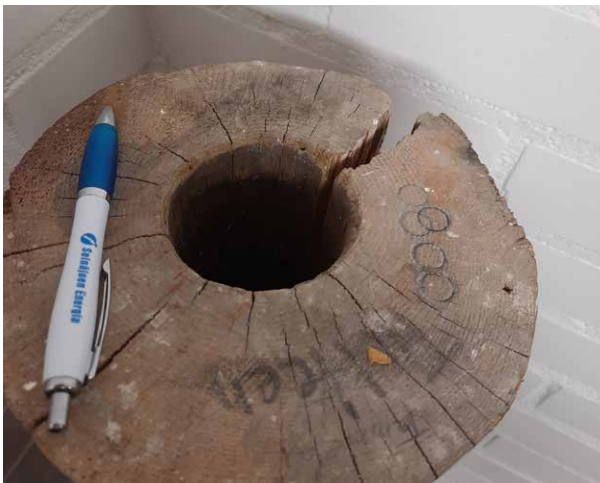
Vanhaa, käytöstä poistettua puuputkea on pala nähtävissä Jouppilanvuoren vesilatoksella.
