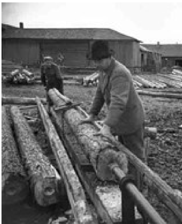
Kuva 3.2. Koneellista puuputkien kairausa Jurvasa vuonna 1948. (Valokuva: J. Kangas 23.9.1948 / Tampereen museoiden kuva-arkisto)
