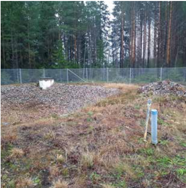
Kuvissa Sikaharjun vedenkäsittelylaitos 2021. Pihan kaksi kaivoa eivät ole enää käytössä, vaan vesi pumpataan uusista, kauempana olevista kaivoista. Suodattimien pesuvesi imeytetään pihan kuoppaan.
