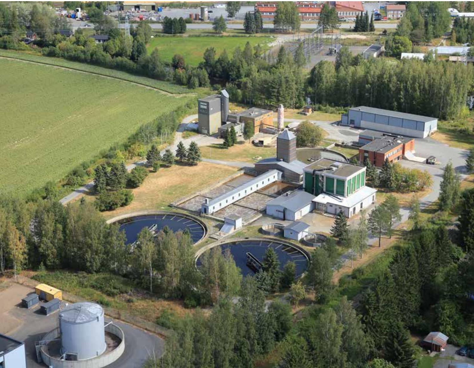
Kuva 5.16 Ilmakuva Seinäjoen jätevedenpuhdistamosta vuonna 2019. (VK 2019)
