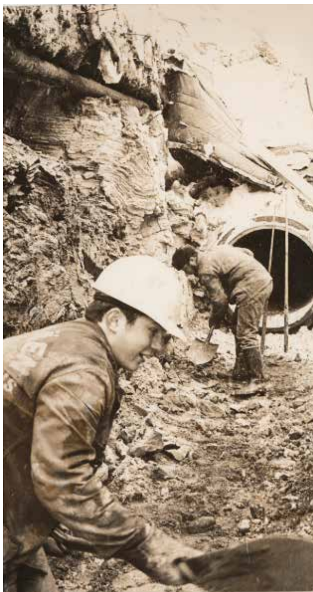
Kuva 5.5 Myös viemäryömailla ryhdyttiin käyttämään suojakypäriä 1970-luvulla. (Viemäryömaa. Porstua-verkkopalvelu.)
