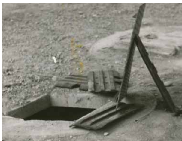
Kuva 5.4 Seinäjoen maakuntakokoelmasta löytyy kuva huonosti suojatusta viemärikaivosta, jonne hukkui poika vuonna 1965. Vieressä kaivon kansi ja varoituskyltti pystyssä. (Onnettomuusviemärikaivo 1965. Porstua-verkkopalvelu.)
