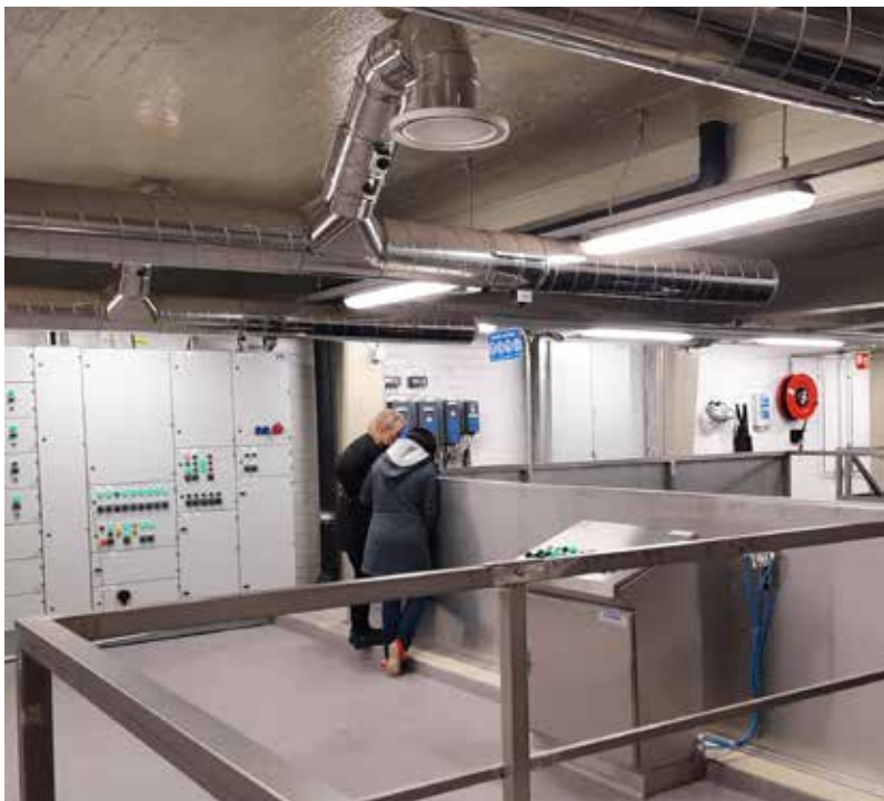
Jouppilanvuoren vesilaitoksen saneeraustyöt saatiin pääosin valmiiksi vuonna 2018. Kuvassa katsotaan allasta, jossa on aktiivihii-lisuodatin.
