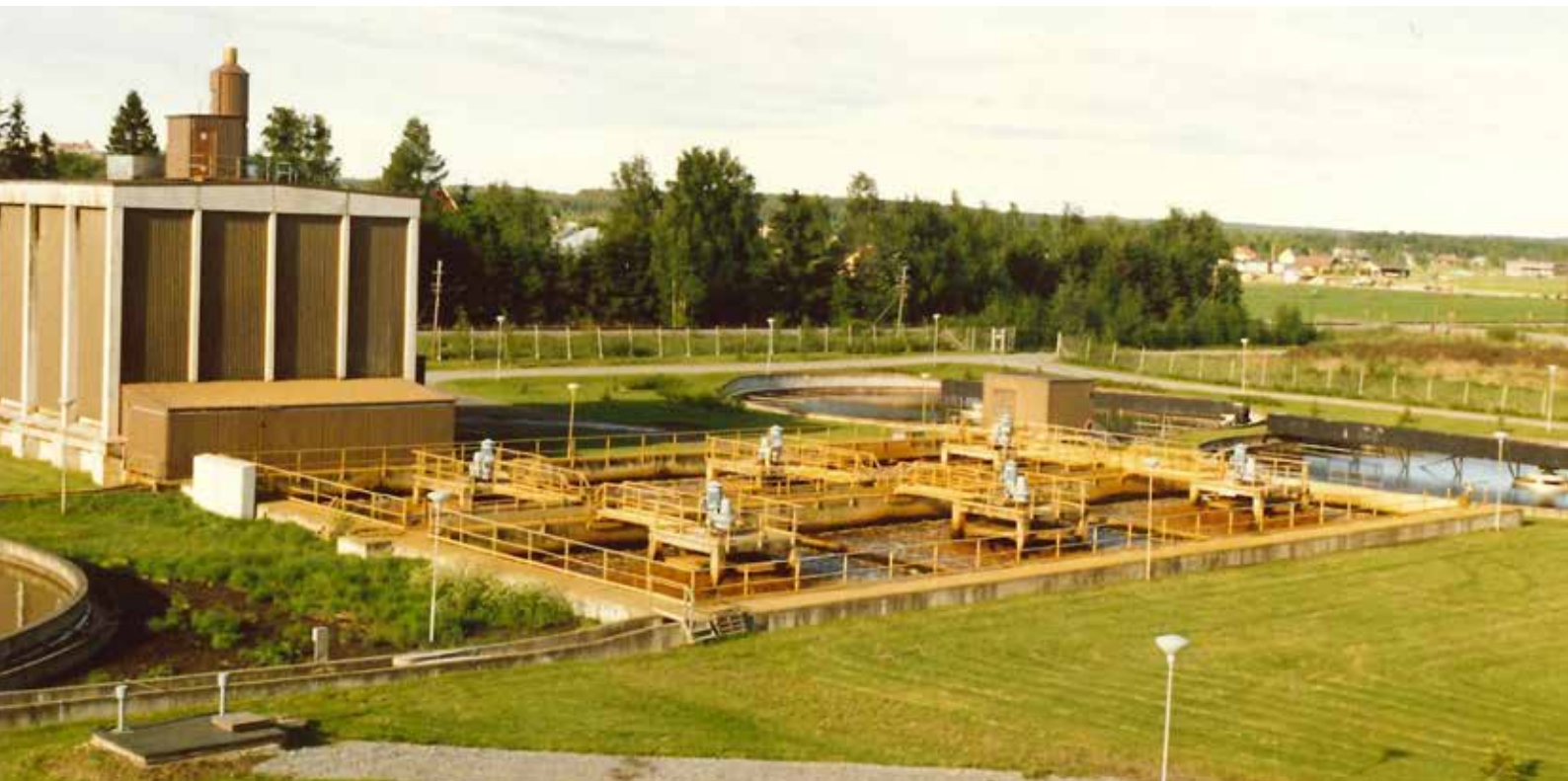
Kuva 5.10 Seinäjoen jätevedenpuhdistamo vuonna 1988 (todennäköisesti): a) Esikäsittelyrakennus, jonka vasemmanpuoleisella nurkalla näkyy sakokaivolietteiden vastaanottoasema, rakennuksen yläkerrassa sijaittivat mm. valvomo-kokoustila, laboratorio ja puhdistamonhoitajan huone, oikealla puolella etuselkeytys b) Vasemmalla meijerijätevedet käsittelevä biosuodatin; keskellä pintailmastimilla varustetut ilmastusaltaat kaikille jätevesille ja oikealla takana jälkiselkeytys. (Pesonen 17.3.2022.)
