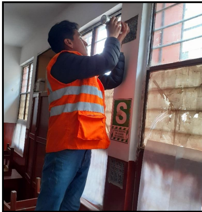
Figura A.6: Ensayo de Esclerometría en la parte superior de la Columna.
