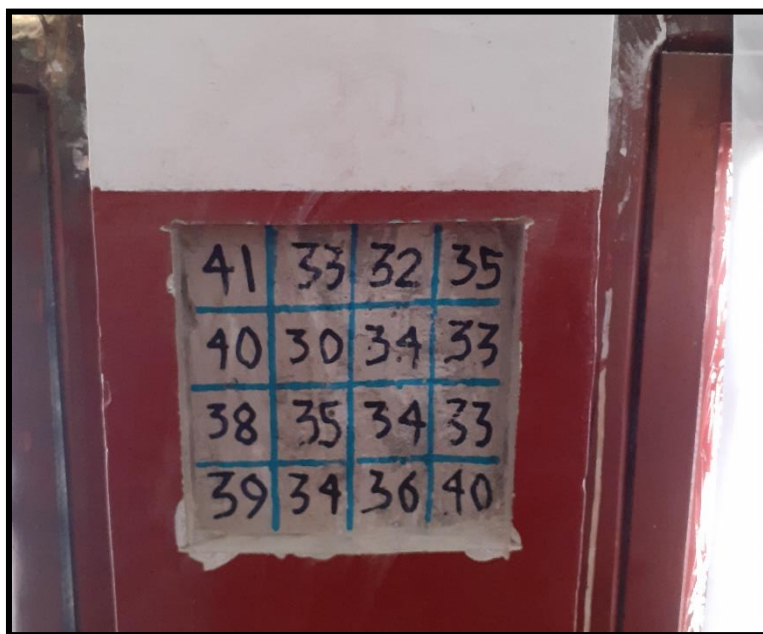
Figura A.2: Ensayo de Esclerometría.
