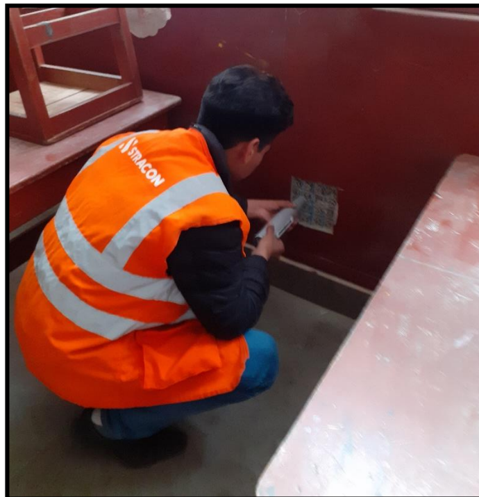
Figura A.4: Ensayo de Esclerometría en parte inferior de la Columna.
