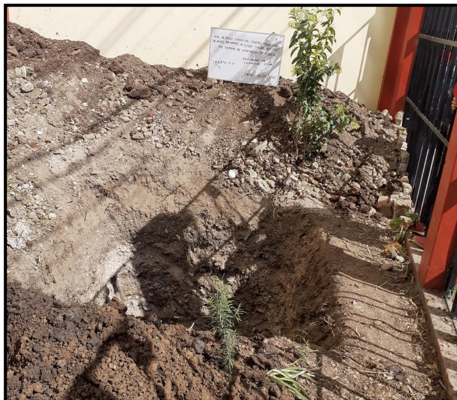
Figura A.9: Excavación manual de la Calicata.
