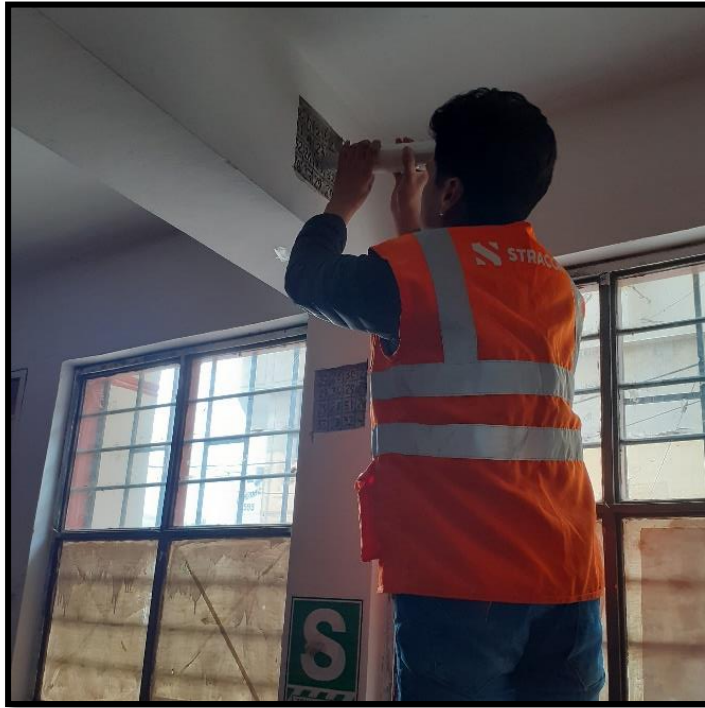
Figura A.7: Ensayo de Esclerometría en la cara lateral de la viga.
