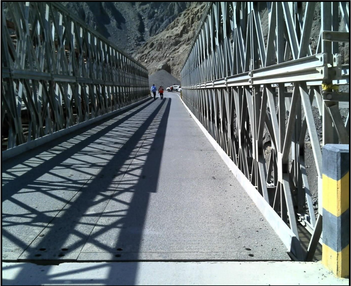
Fotografía 2: Vista del Puente Chuquicara
