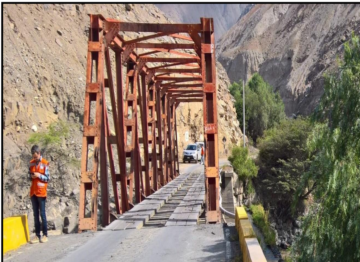
Fotografía 6: Vista del Puente Tablachaca I
