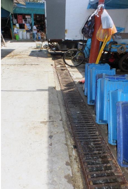
Rejilla del alcantarillado en mal estado en el mercado de pescados y mariscos (Elaboración propia)
