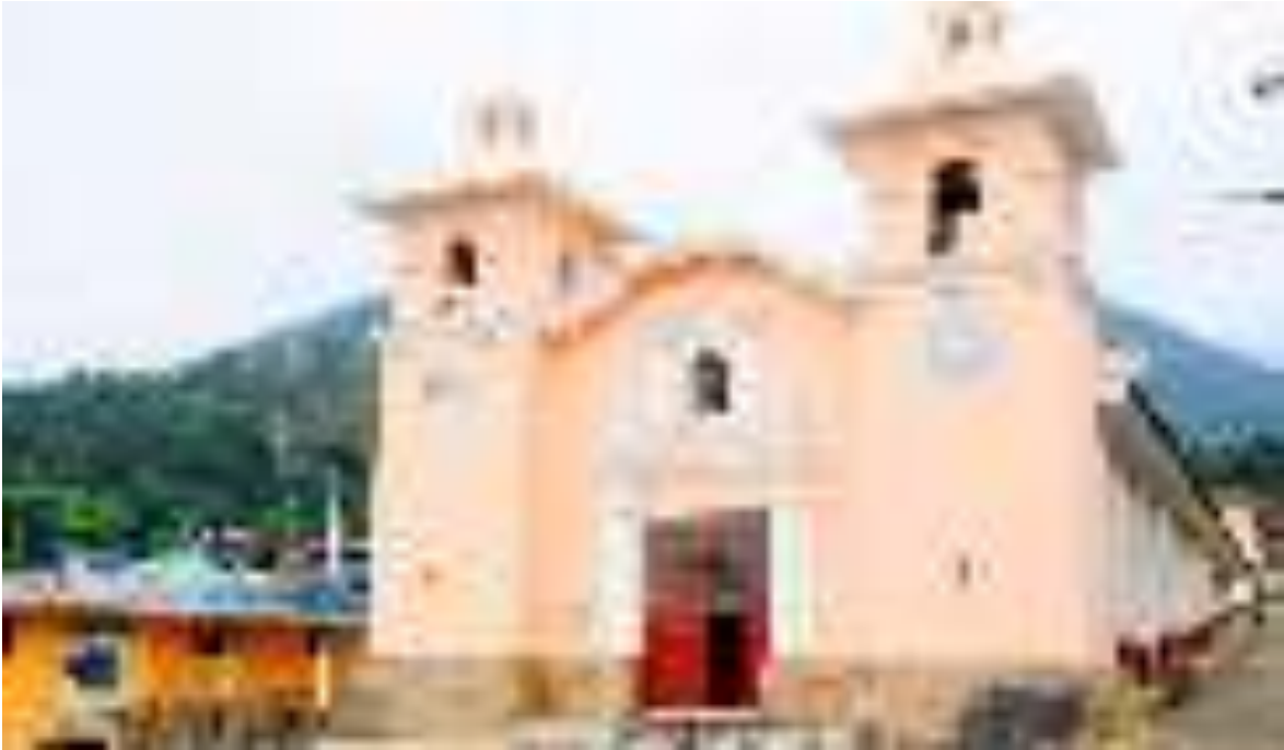
Figura 1. 99. Iglesia mayor del Distrito de Canchaque.
