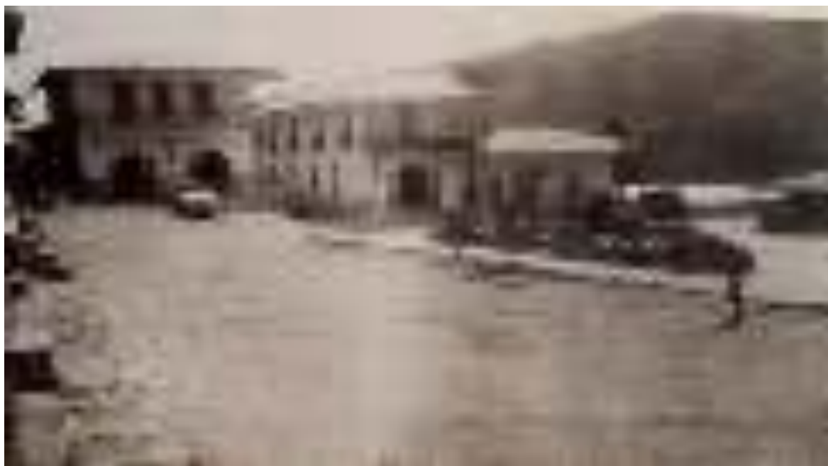
Figura 1. 14. Viviendas antiguas del Distrito de Canchaque.
