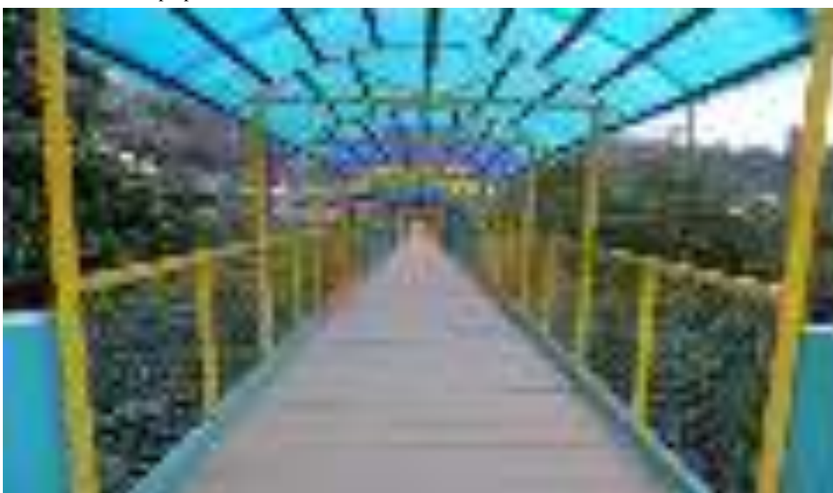
Figura 1. 101. Puente colgante peatonal del Distrito de Canchaque
