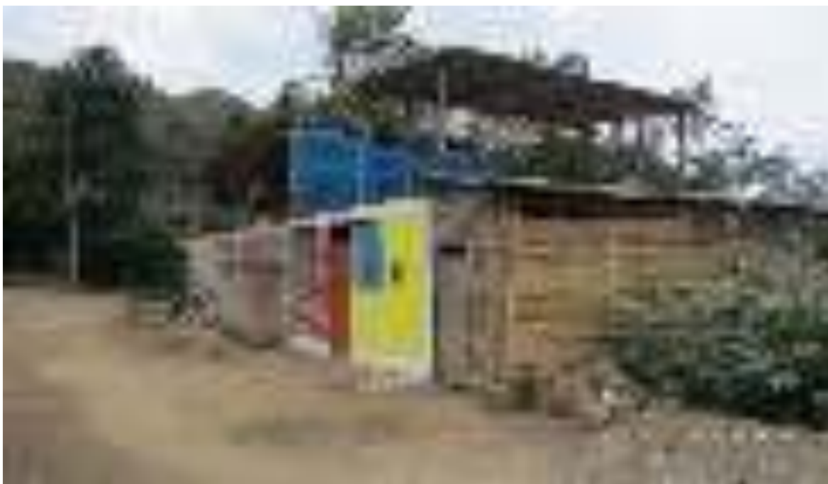
Figura 1. 37. Vivienda elaborada de ladrillo.
