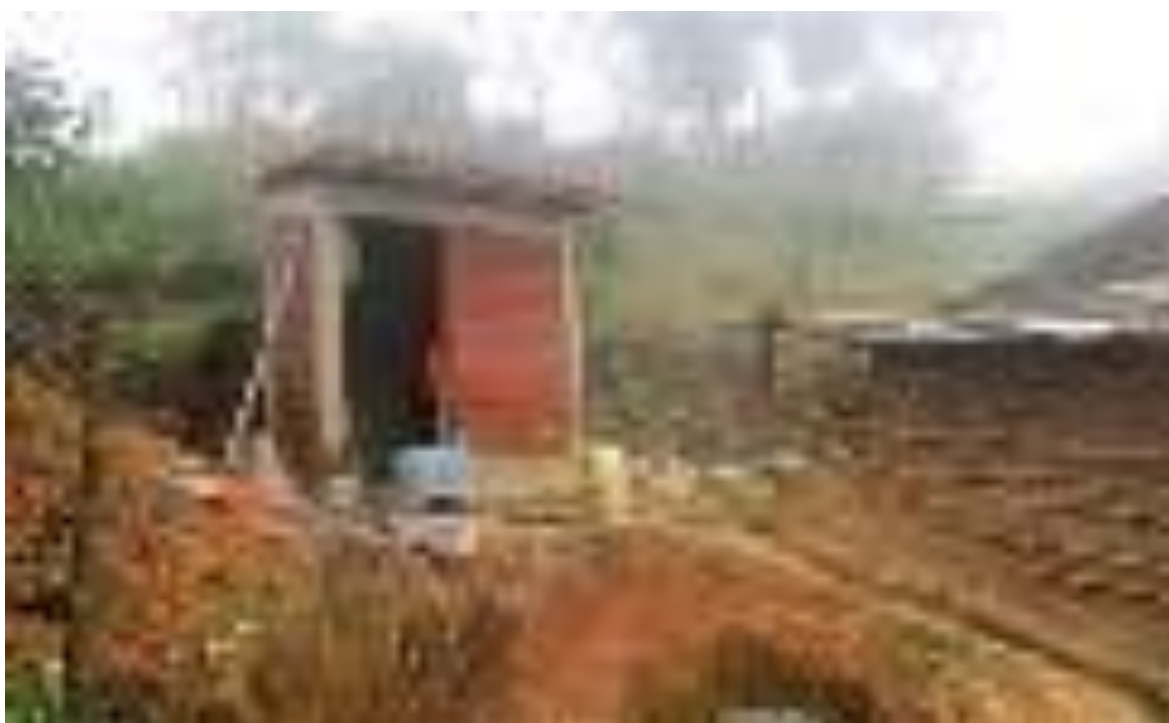
Figura 1. 39. Instalación de baños con biodigestor.
