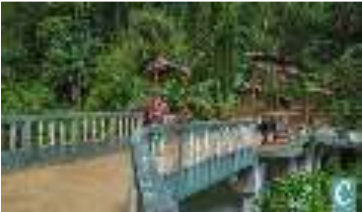
Figura 1. 100. Puente de la Chununa.
