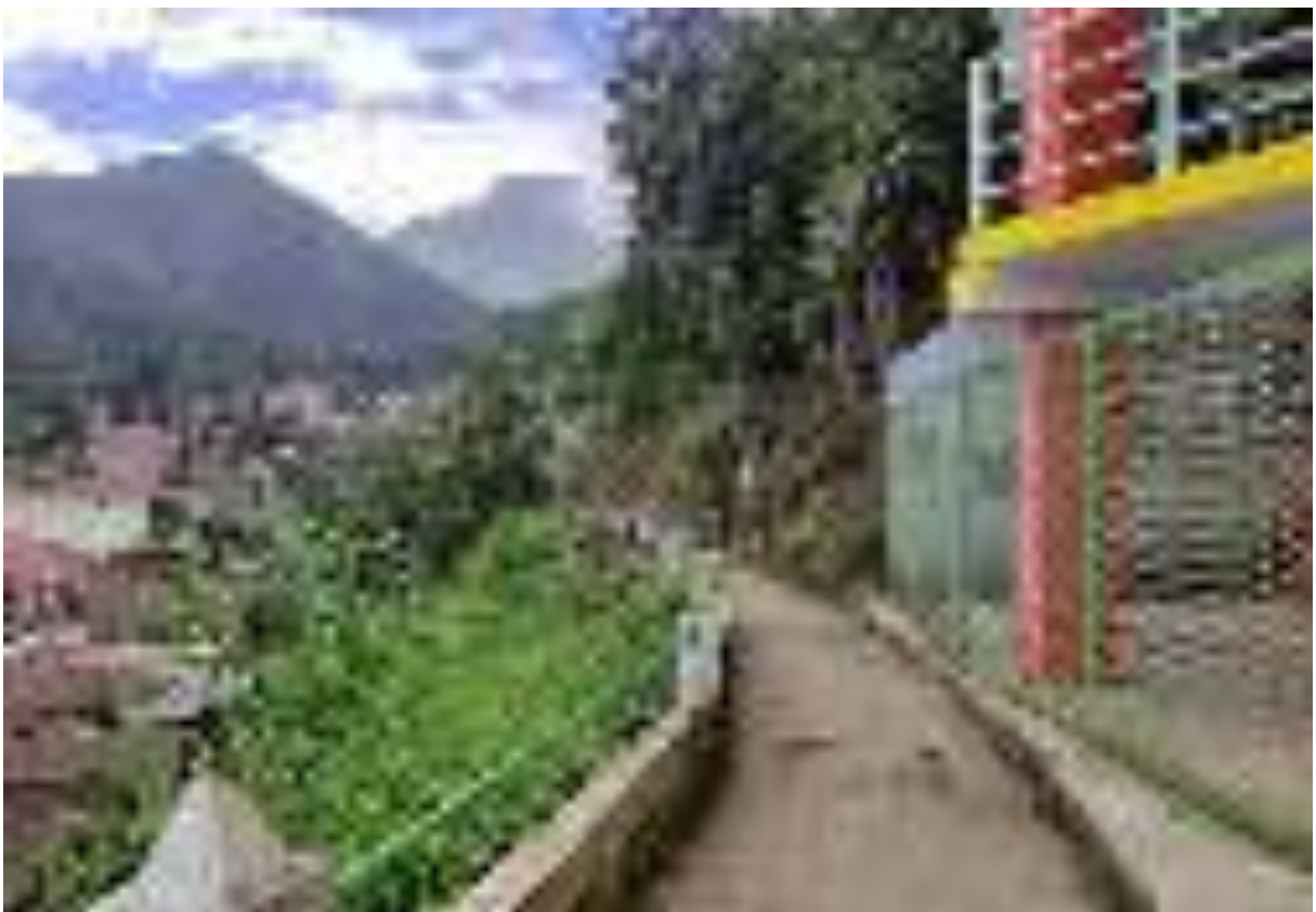
Figura 1. 182. Estado actual del sitio del proyecto alameda gastronómica pecuaria productiva. Fuente: elaboración propia
