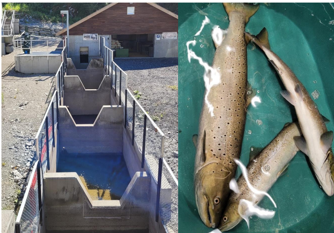
Bilde 1 og 2. Fisketrappa som leder inn til fangsthuset ved fiskesperra (venstre bilde, vannet i trappa er slått av) og bedøvet sjørret som senere skal flyttes opp ovenfor sperra (høyre bilde). Foto: Vegard G. Sollien, Veterinærinstituttet.
