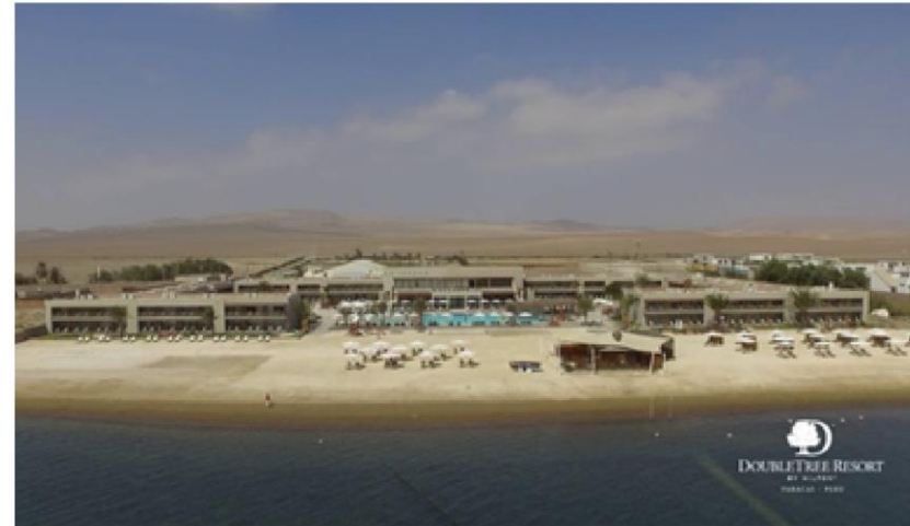
Figura 1. Vista Aérea - Doubletree by Hilton Resort Paracas (Fuente: https://es.perutravelling.com , 2016)
