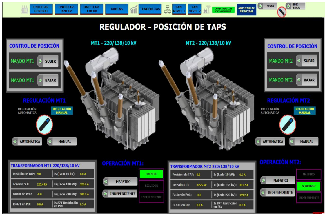
Figura 47. Supervisión y control de transformadores de alta tensión. Fuente. Elaboración propia.
