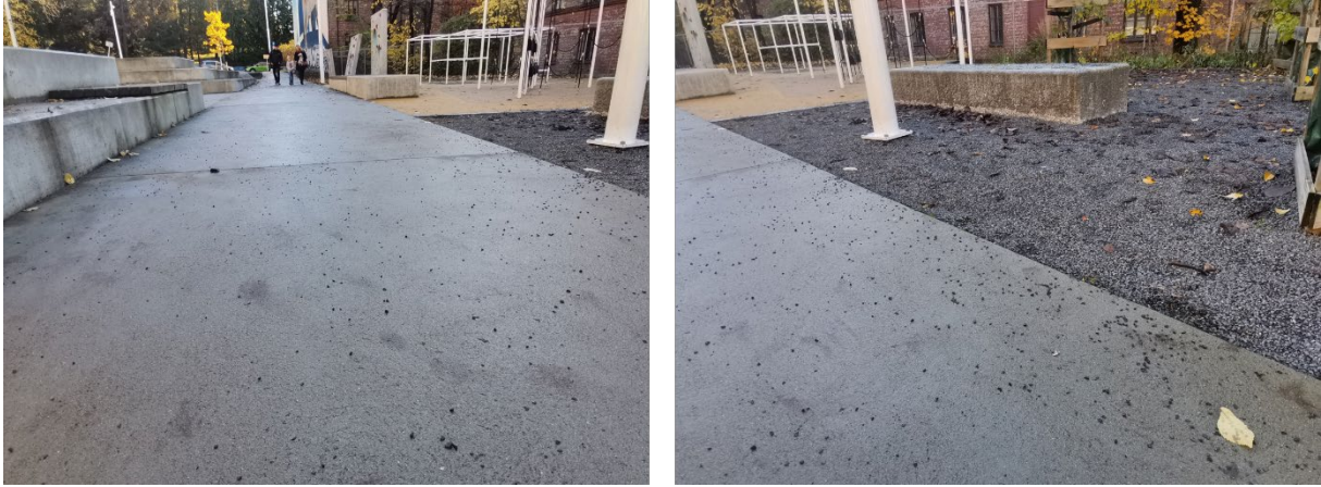
Figur 6.14 Grusdekket ved frukttrærne sprer seg ut i byrommet, og fører til irritasjon hos de som holder på med rulleaktiviteter. I tillegg medfører det vedlikeholdsutfordringer.
