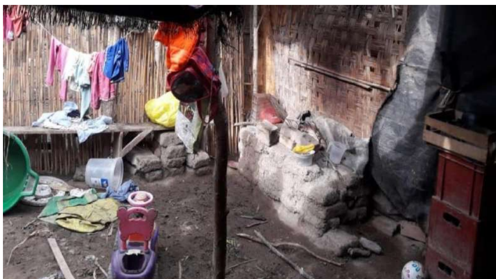
Figura 88: Fotografía de una vivienda de quincha en Callanca.
