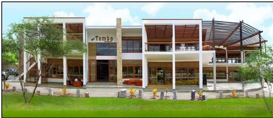
Figura 80: Fotografía de la infraestructura del centro campestre "El Tambo".
