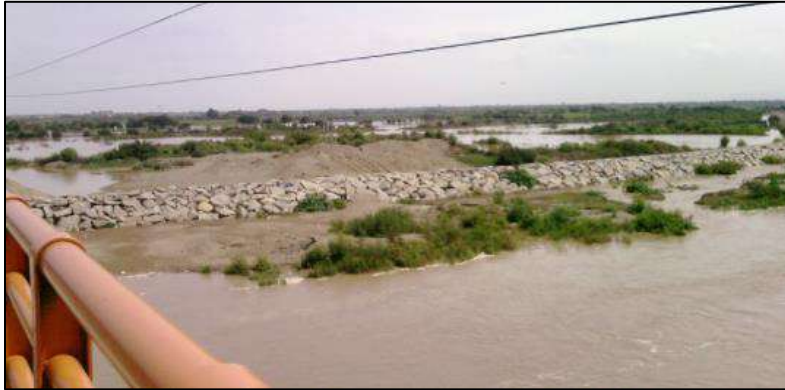
Figura 27: Fotografía del dique enrocado en el Rio Reque.
